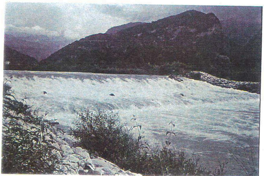
Photo 3.3 - ARVE. Seuil sous-fluvial bloquant l'érosion ré-gressive en aval de Cluses. L'ouvra- ge, construit en 1983, était affouillé 10 ans plus tard, comme en témoigne le dégagement des fonda- tions (Cliché : J.-L. Peiry, 1993).
