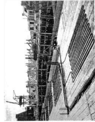
FIG. 2. — SERPENTINS A FLEUR DU PLAFOND APRÈS LE DECOFFRAGE.
