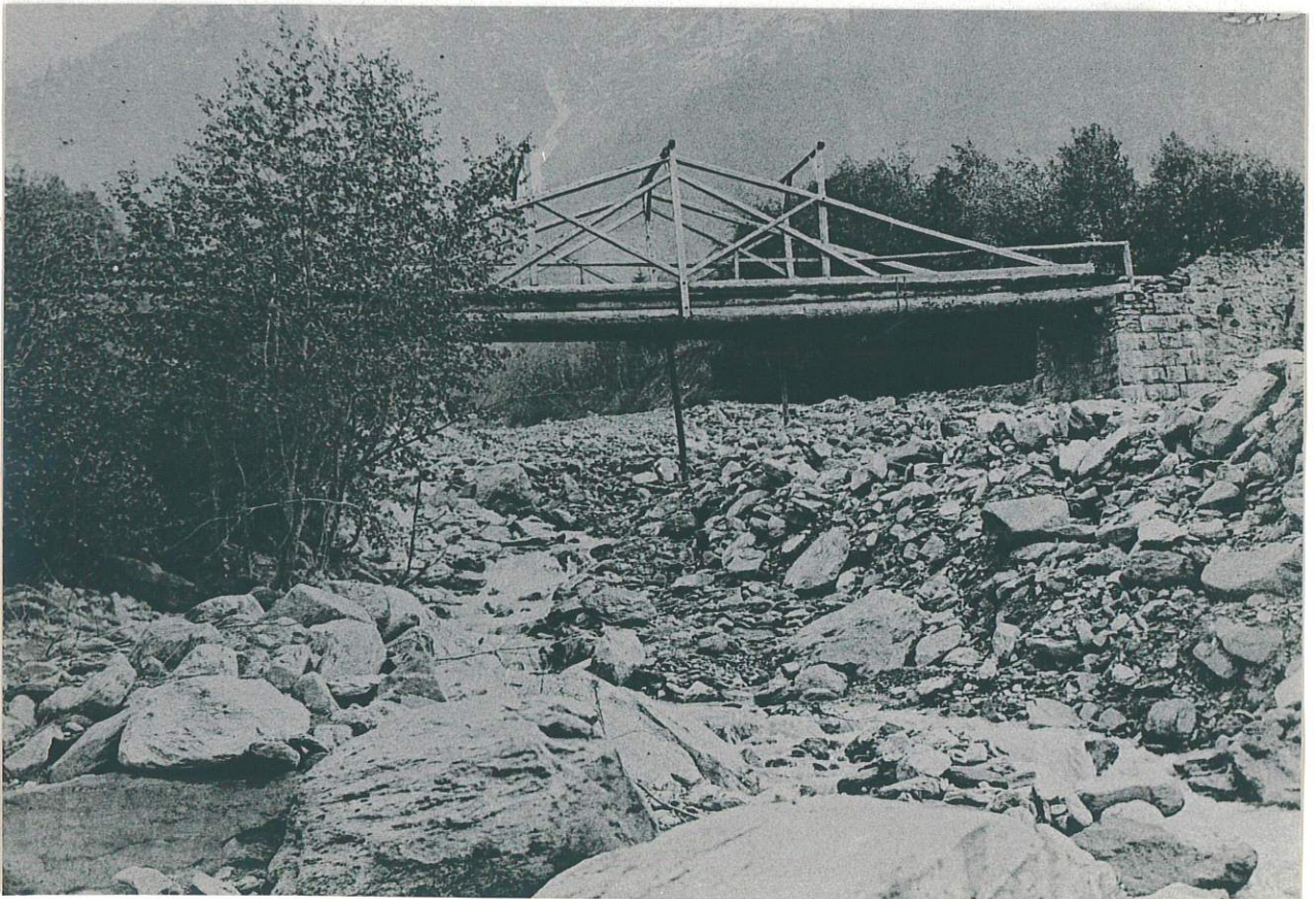
Figure 4.14 : Vues diachroniques du chenal de la Griez : A) auto-curage du chenal sur la partie inférieure du cône de déjection, après les laves d'août 1895 ; B) exhaussement du chenal en 1897 entre deux crues exceptionnelles ; le lit sera à nouveau curé par les coulées du 20 juillet 1898 (Collection R.T.M. 74).
