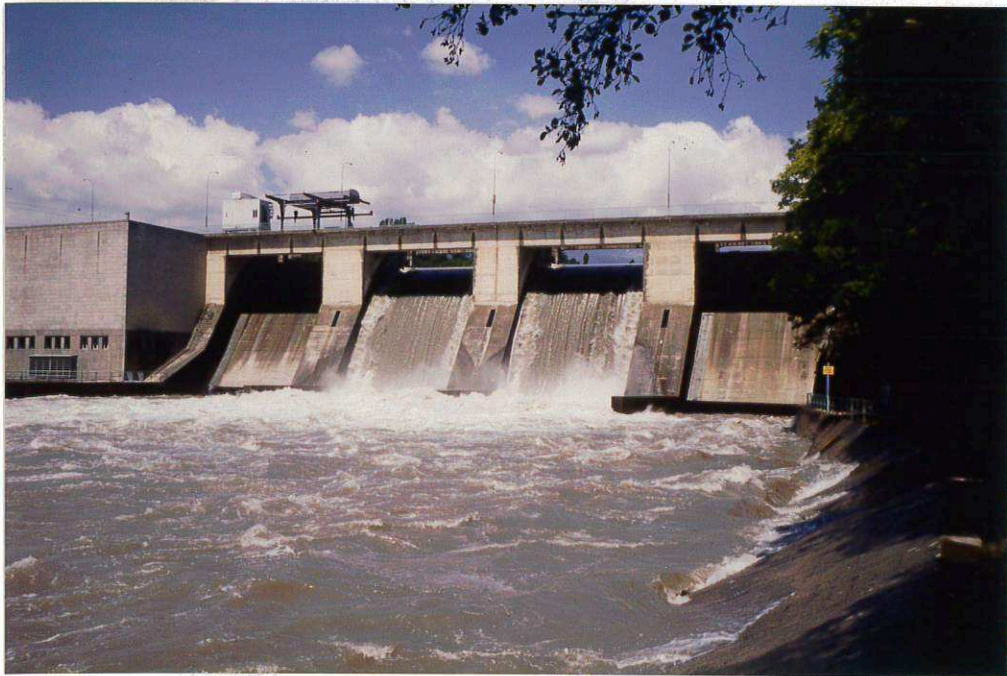
Figure 7.2 : Vue aval des vannes du barrage de Verbois (photographie de l'auteur).
