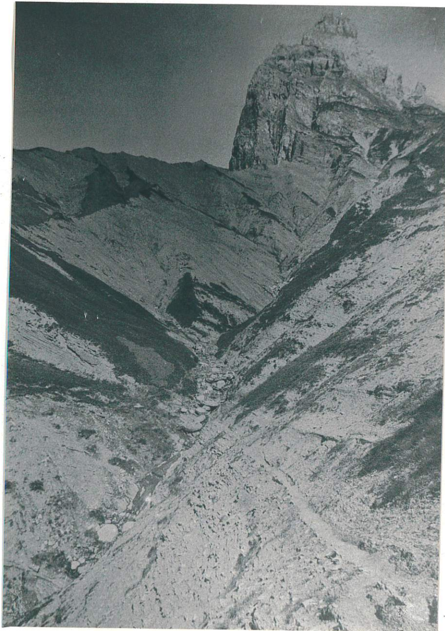
Figure 4.25 : Vues diachroniques du bassin de réception du torrent de Reninges-Ruttets. La végétation plantée au début du siècle n'a pas pu se développer ; quelques arbres subsistent sur les interfluves : A) 1892 (Collection R.T.M. 74) ; B) 1986 (photographie de l'auteur).
