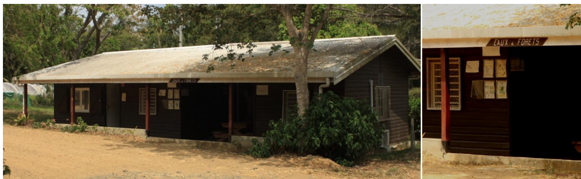
Photo n° 5 : La station forestière du district de Koné, construite en 1972, héritée des Eaux et Forêts et appartenant aujourd'hui à la Province nord (Photos de l'auteure, 2014)
