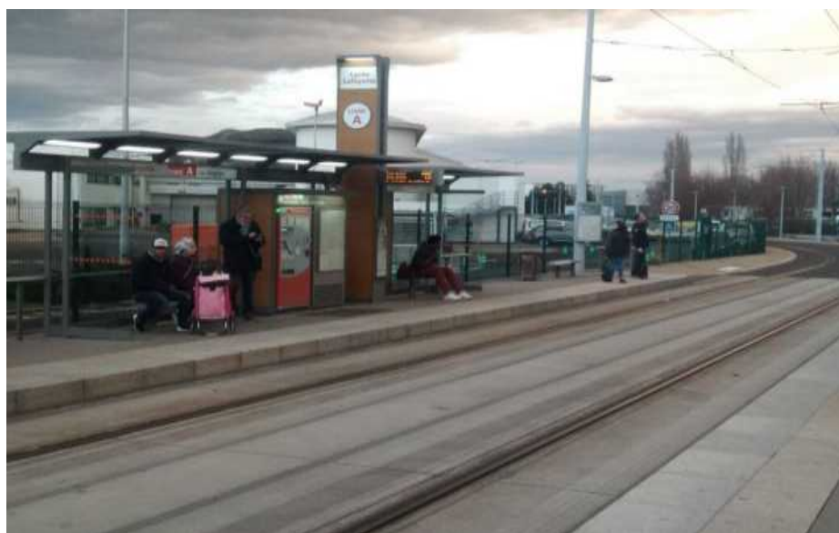
Photo 2: Arrêt de tramway « Lycée Lafayette » accessible aux PMR (Source : Auteur)
