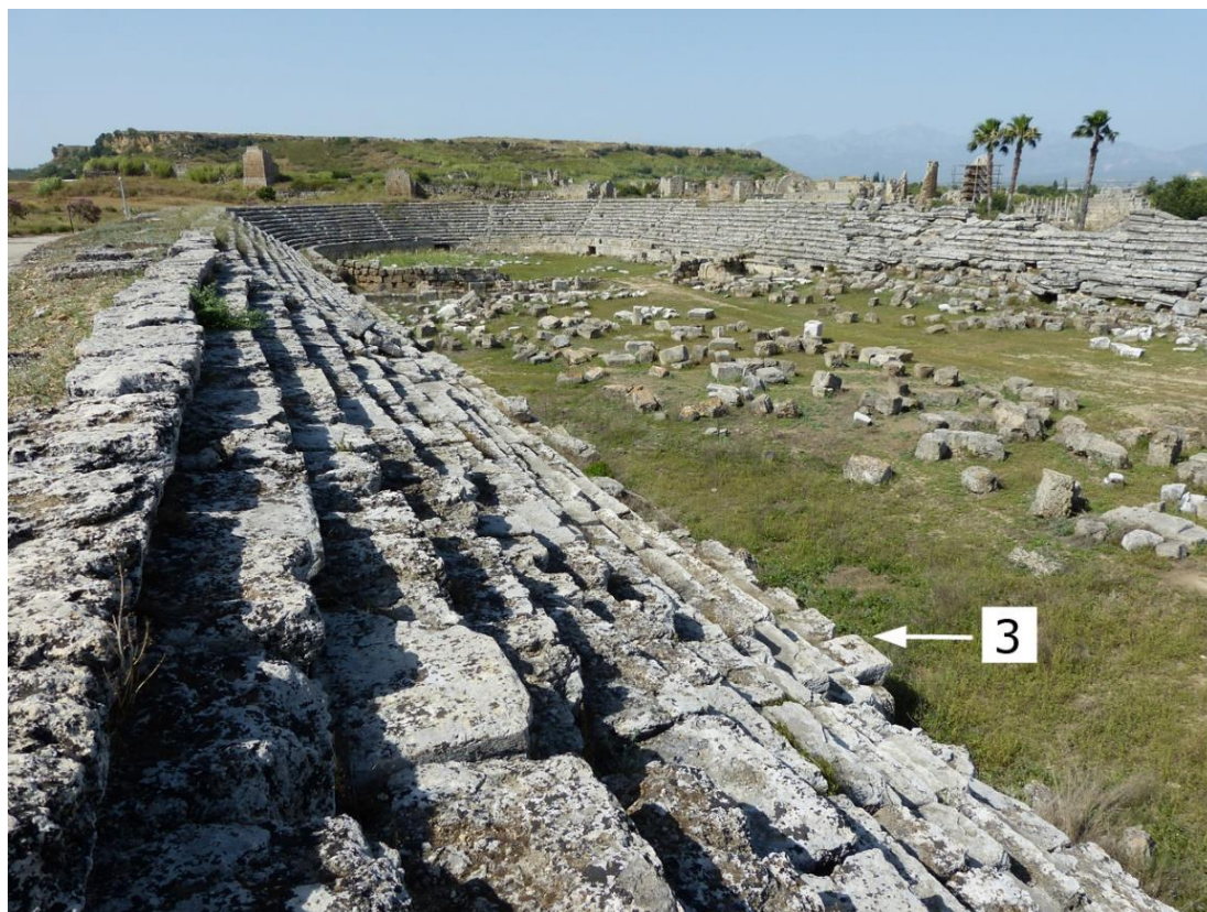
Figure 177 : Trou d'encastrement 3 situé hors de la zone transformée en amphithéâtre
