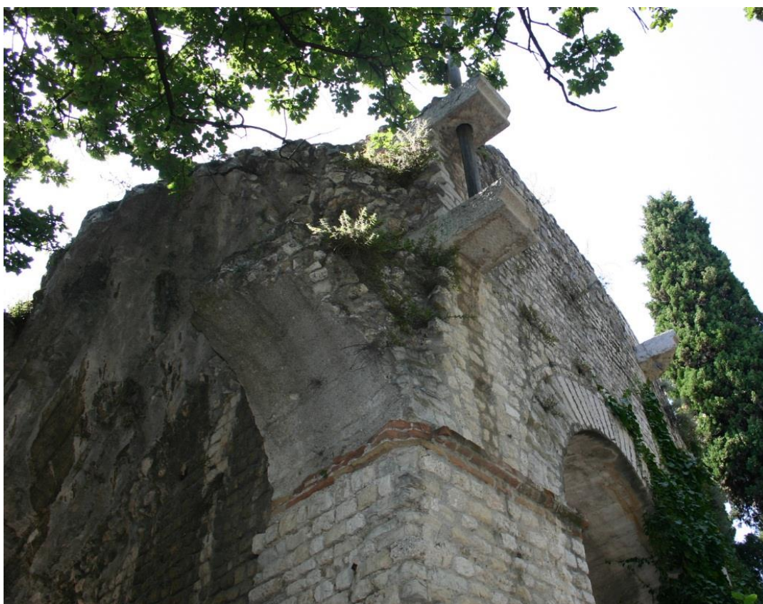
Figure 33 : Mur d'enceinte de l'amphithéâtre de Cimiez pourvu de consoles pour le vélum
