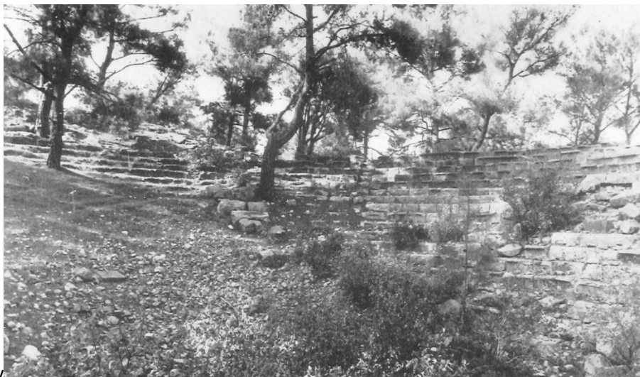
Figure 128 : Théâtre de Rhodiapolis avant son dégagement
