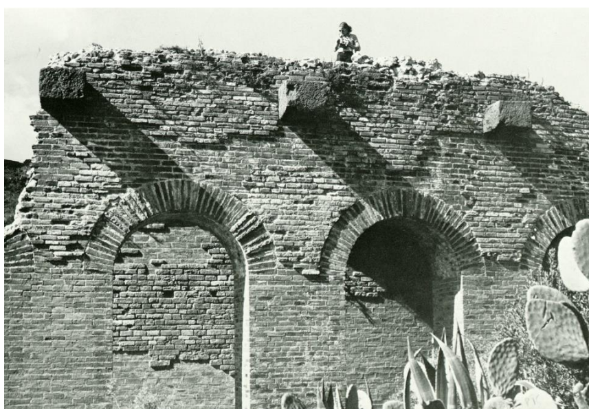
1. wiederhergestellte Außenwand der Cavea
