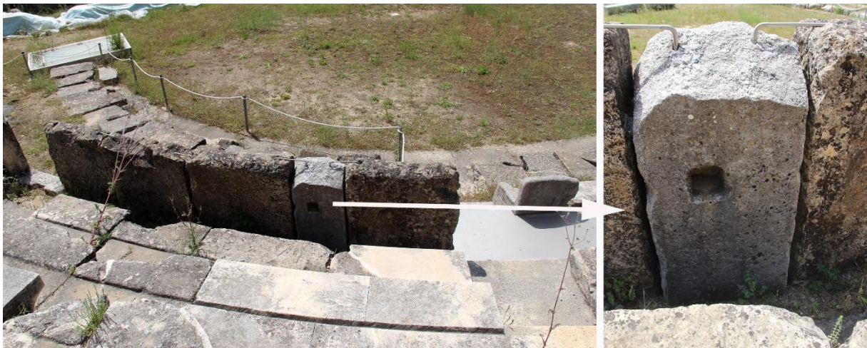
Figure 72 : Pierre de réemploi avec un trou d'encastrement sur le parapet du théâtre de Maronée
