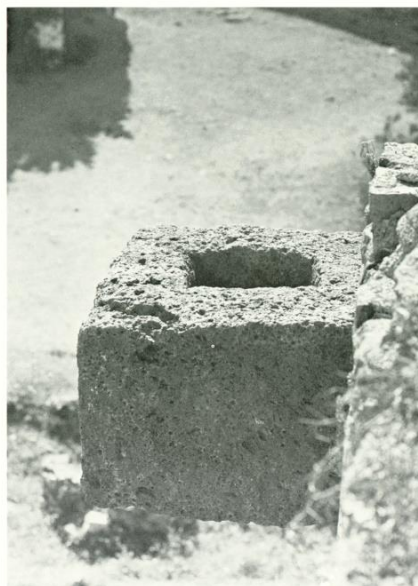
Figure 203 : Consoles de soutien du vélum sur le théâtre de Taormine
