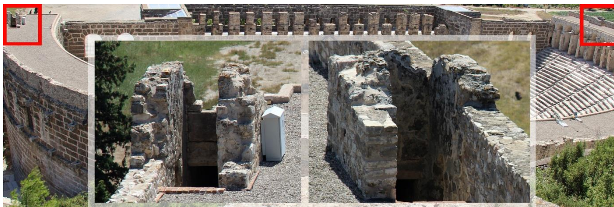
Figure 160 : Deux accès au toit de la porticus pour la manœuvre du vélum
