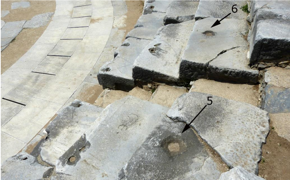
Figure 83 : Trous d'encastrement 5 et 6 dans les gradins du théâtre de Philippes
