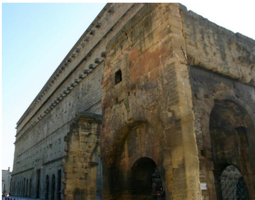
Figure 9: Consoles situées derrière le mur de scène du théâtre d'Orange
