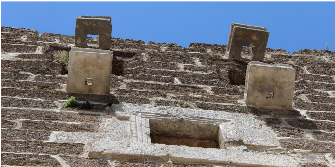
Figure 13 : Consoles 1 à 19 situées derrière le mur de scène du théâtre d'Aspendos (cf. figure 16)
