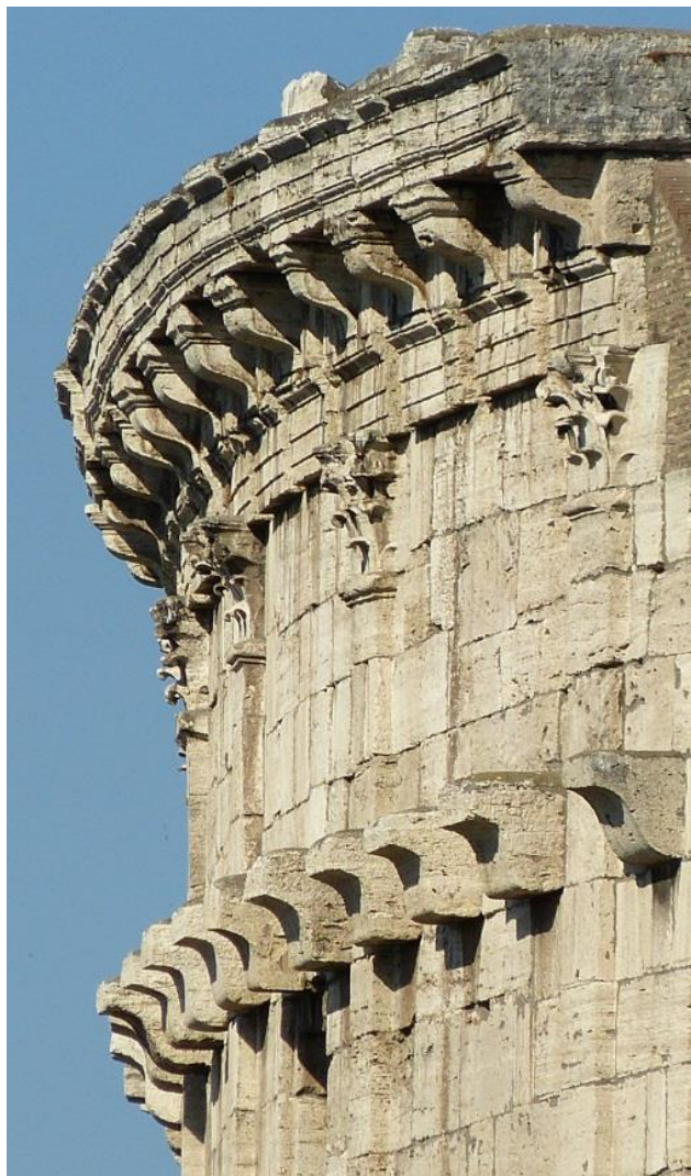
Figure 102 : Consoles de soutien du vélum
