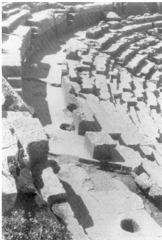
Figure 207 : Partie nord du diazôma du théâtre du Letôon de Xanthos avec les trous d'encastrement pour les mâts du vélum
