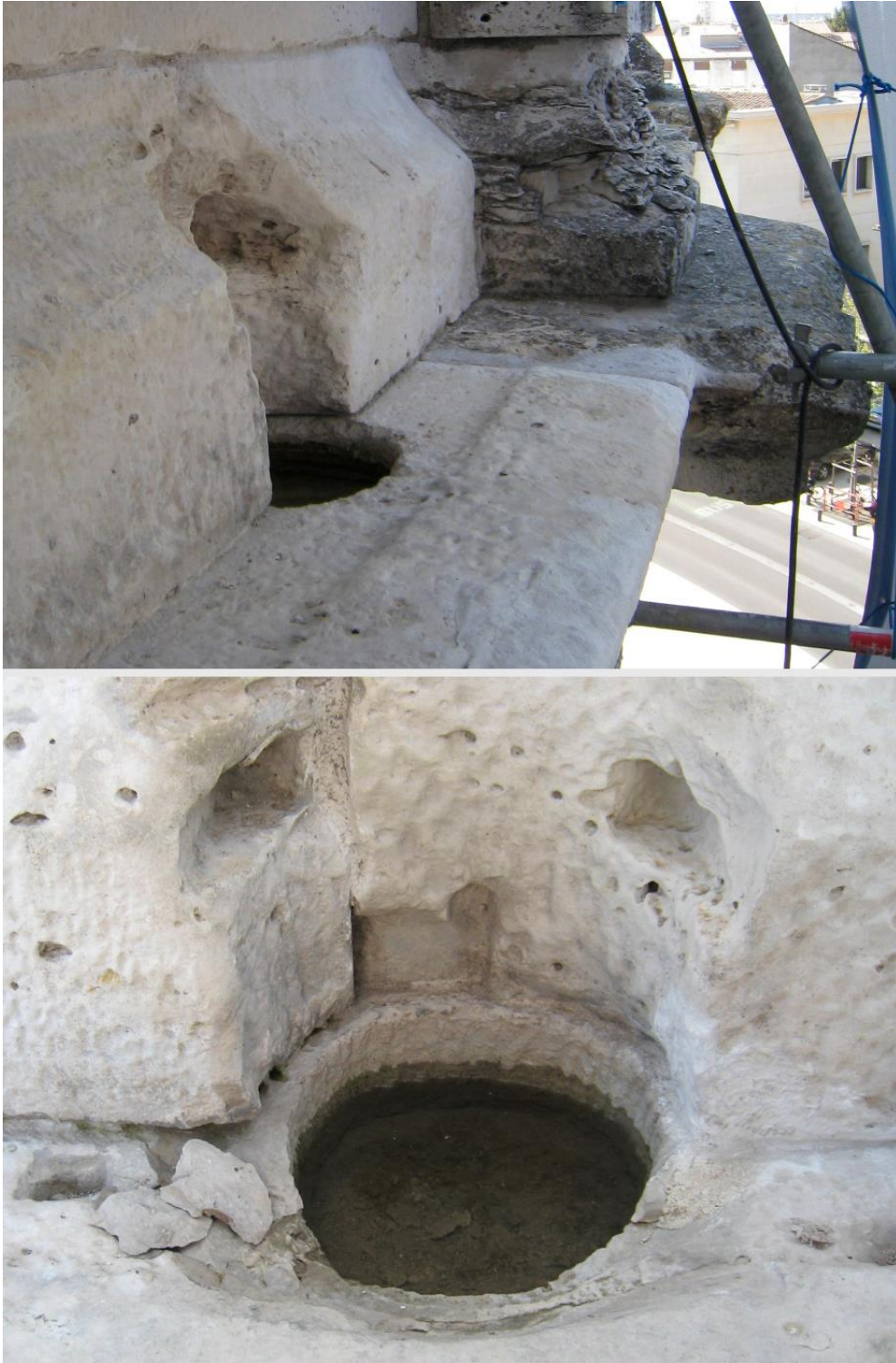
Figure 37 : Corniche pour le soutien des mâts du vélum sur l'amphithéâtre de Nîmes
