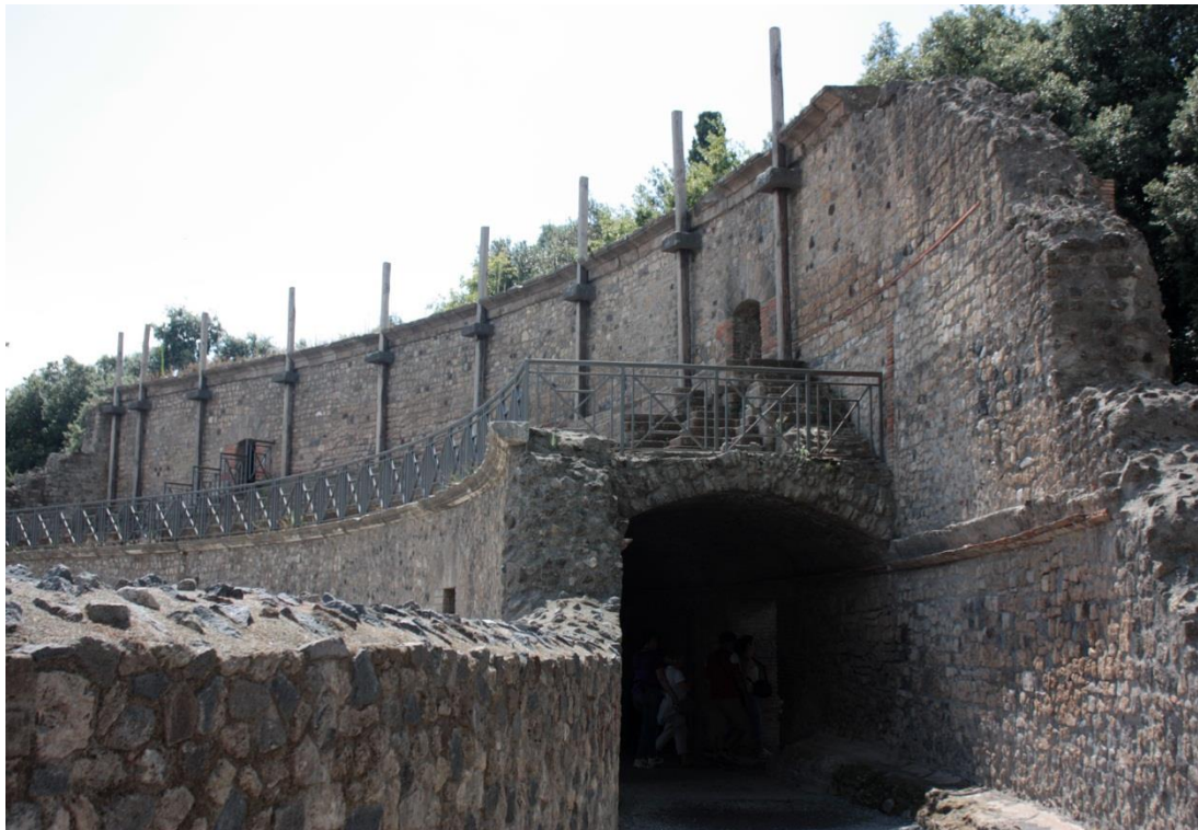
Figure 91 : Consoles percées pour les mâts sur le grand théâtre de Pompéi
