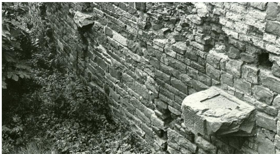
Figure 94 : Les consoles de soutien du vélum sur le théâtre de Trieste
