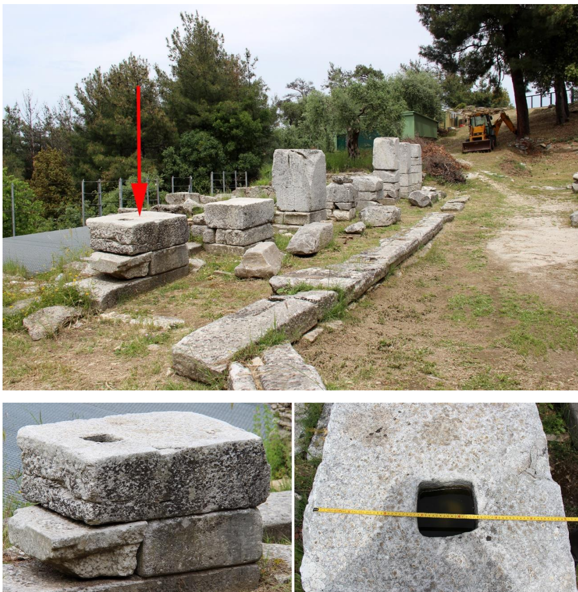
Figure 62 : Console portant un trou d'encastrement sur le théâtre de Thasos
