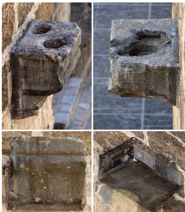
Figure 155 : Les deux consoles situées à l'intérieur du théâtre côté nord et sud du mur de scène
