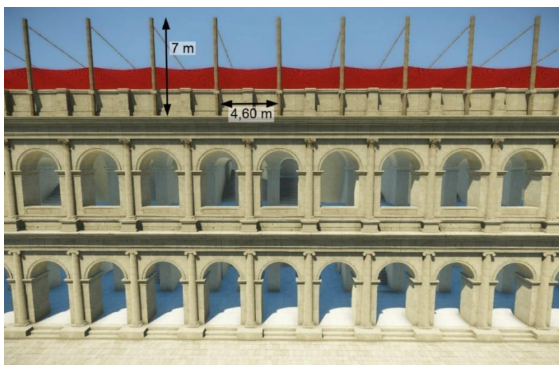
Figure 224 : Implantation des mâts sur l'attique du stade de Domitien si ce dernier est couvert d'un vélum soutenu par des cordes (30 m ou 44 m de portée)
