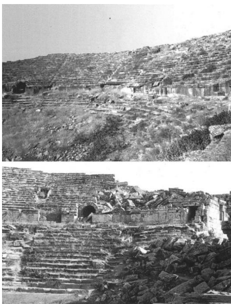
Figure 140 : Cauea du théâtre de Hiéropolis côté nord et côté sud en 1957
