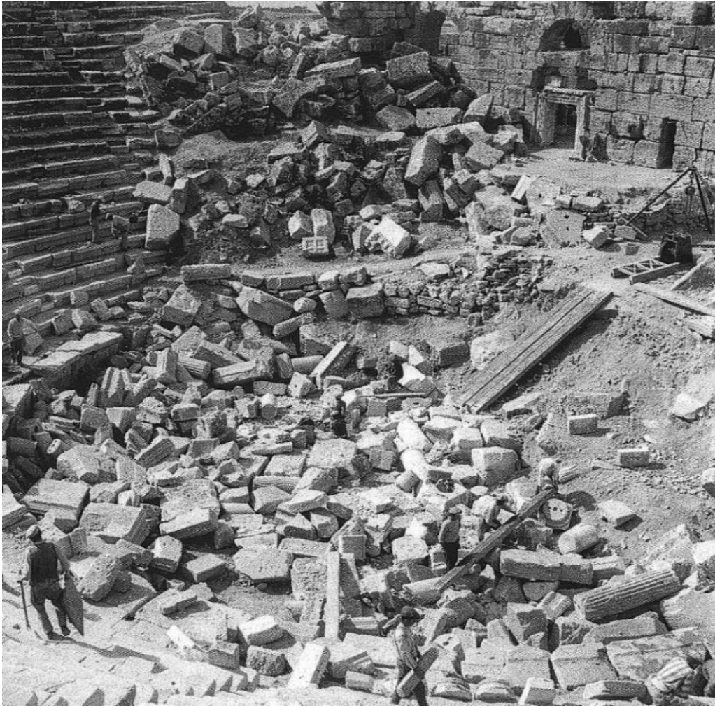
Figure 141 : Cauea du théâtre de Hiérapolis avant la restauration
