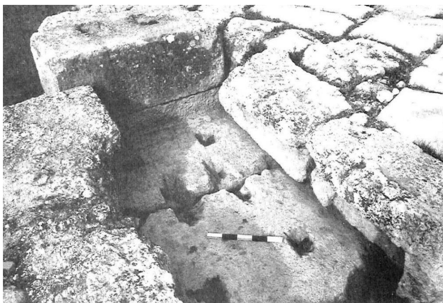
Figure 198 : Trous d'encrage dans un bloc maçonné du théâtre nord de Jérash
