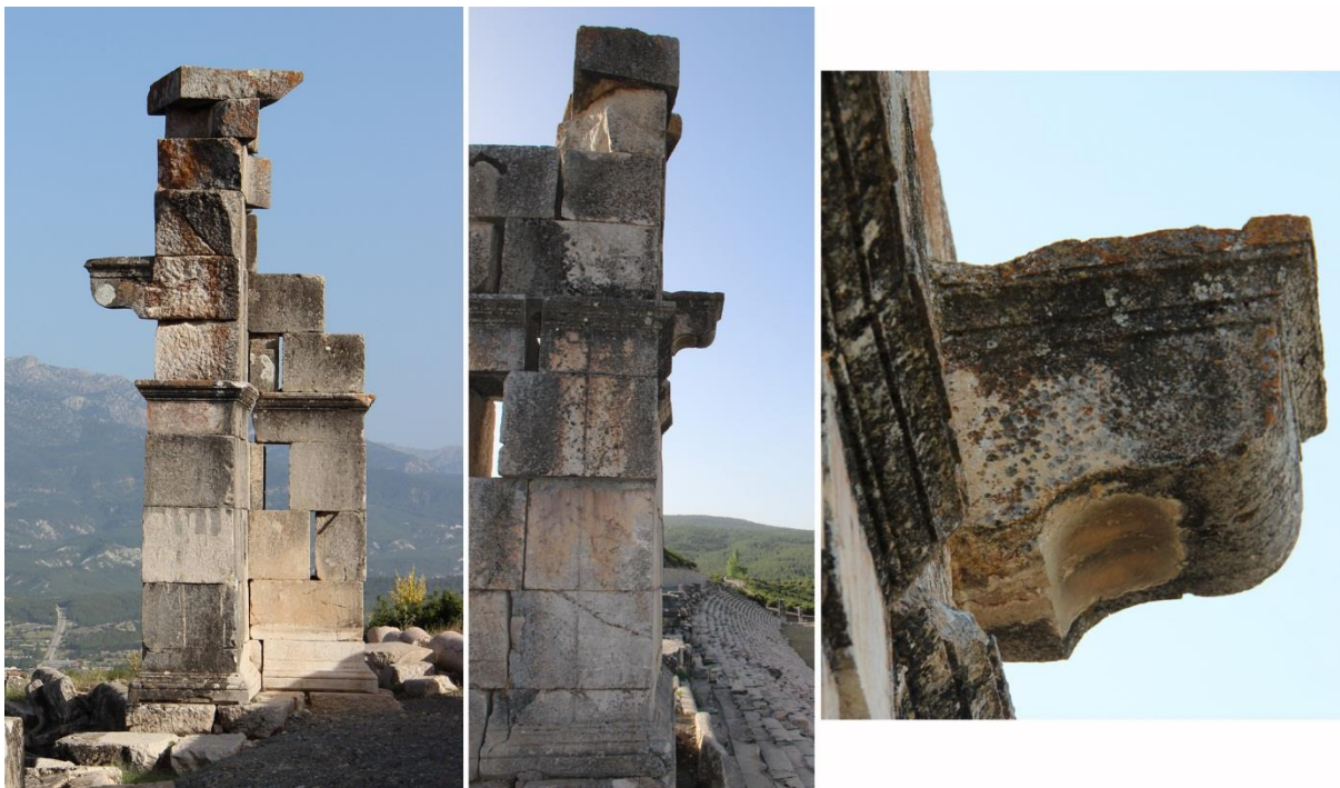
Figure 167 : Console du stade de Cibyra vue du côté nord, sud et du dessous
