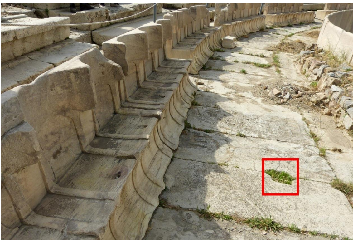
Figure 53 : Première rangée de trous d'encastrement rectangulaires sur le théâtre de Dionysos à Athènes
