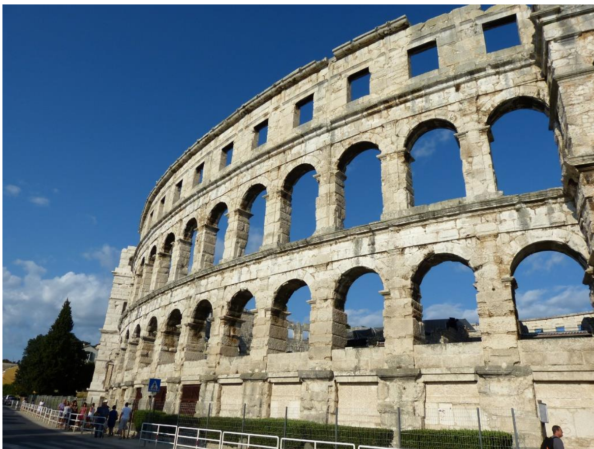
Figure 199 : Façade extérieure de l'amphithéâtre de Pula
