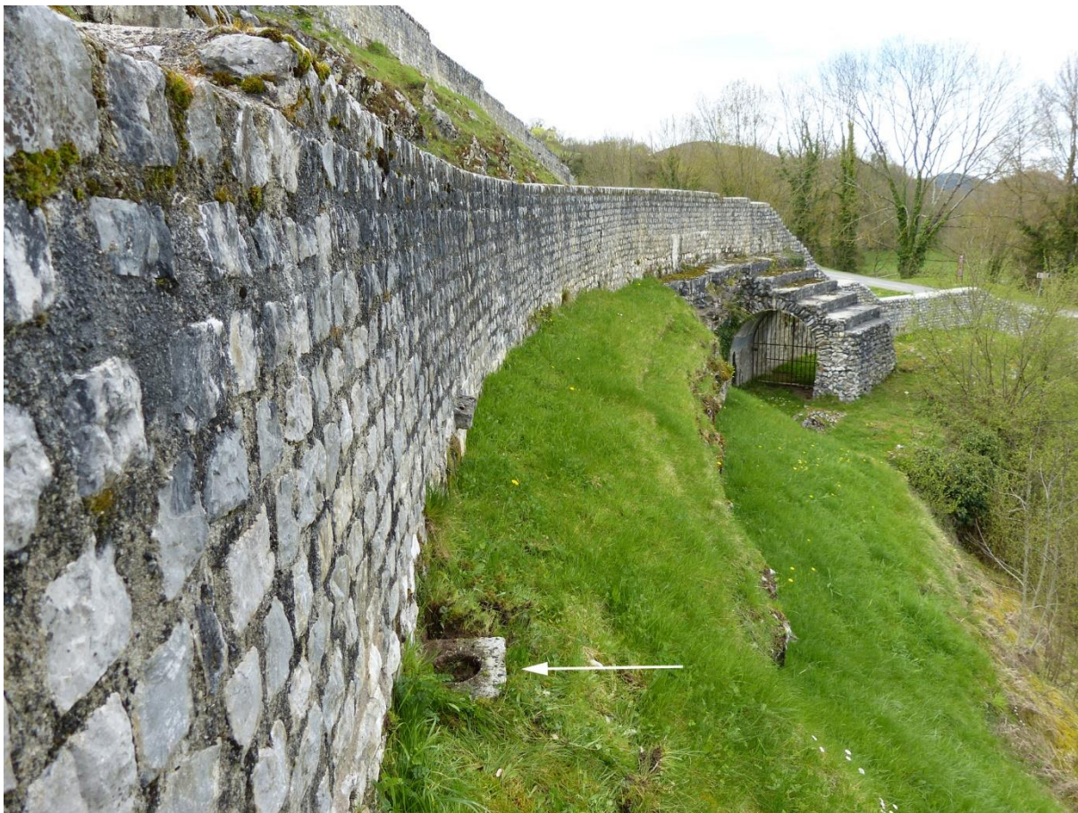
Figure 14 : Coté intérieur du mur d'enceinte du théâtre de Saint-Bertrand de Comminges avec une console de soutien du vélum
