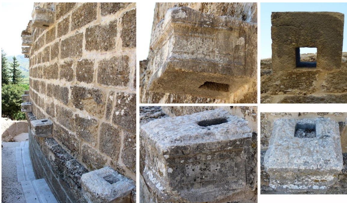
Figure 154 : Consoles situées derrière le mur d'enceinte de la cauea
