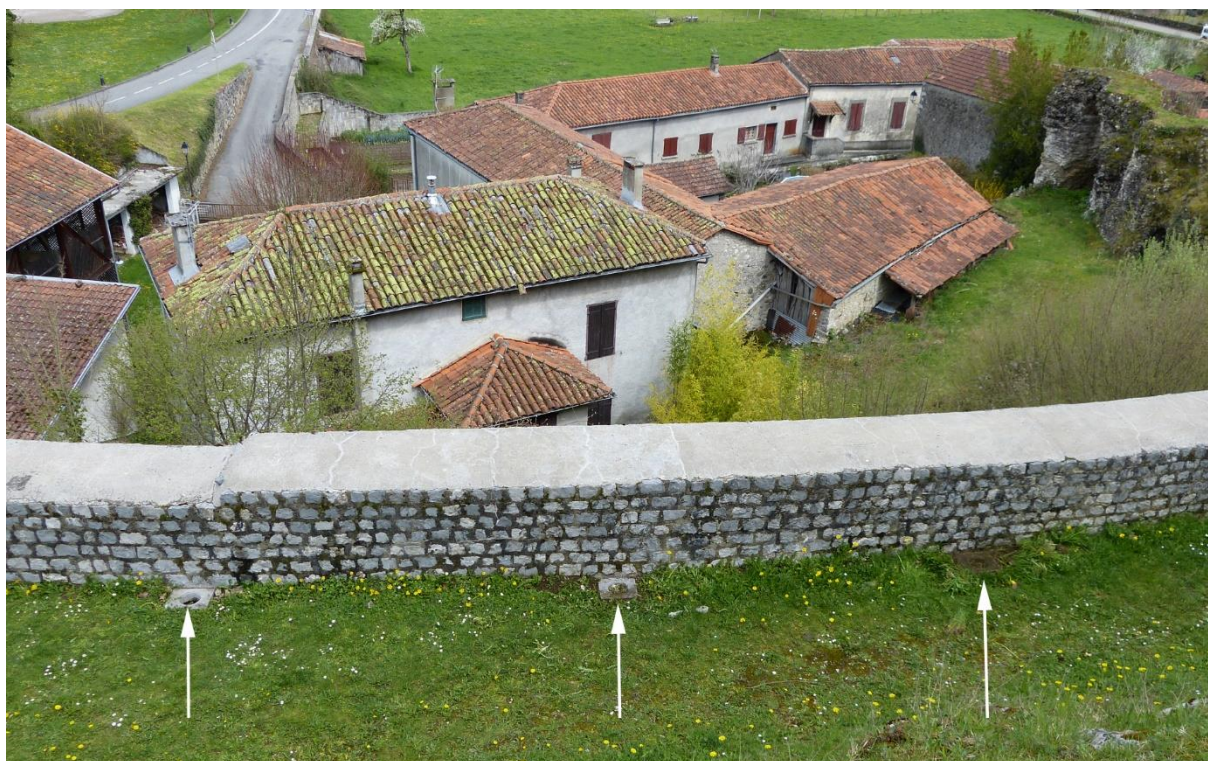
Figure 13 : Coté extérieur du mur d'enceinte du théâtre de Saint-Bertrand de Comminges avec trois consoles de soutien du vélum
