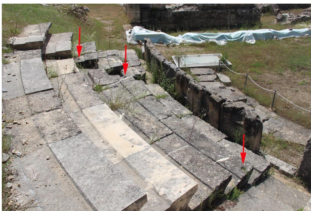
Figure 70 : Trous d'encastrement de petite section dans les gradins du théâtre de Maronée
