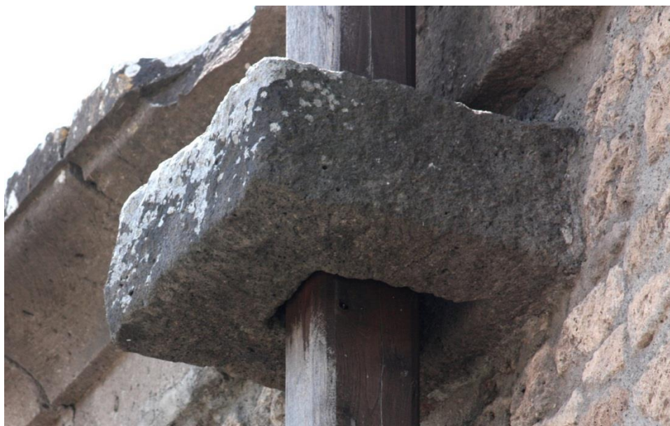
Figure 92 : Gros plan sur une des consoles percées du vélum sur le grand théâtre de Pompéi
