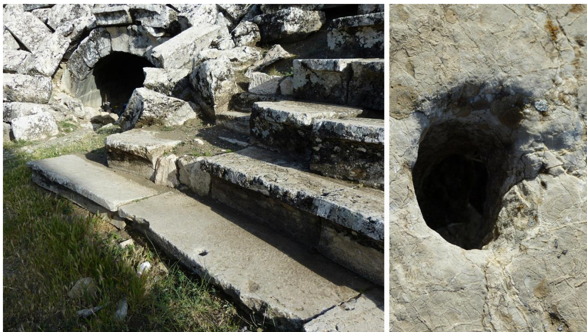
Figure 172 : Trou débouchant dans le podium du stade de Cibyra
