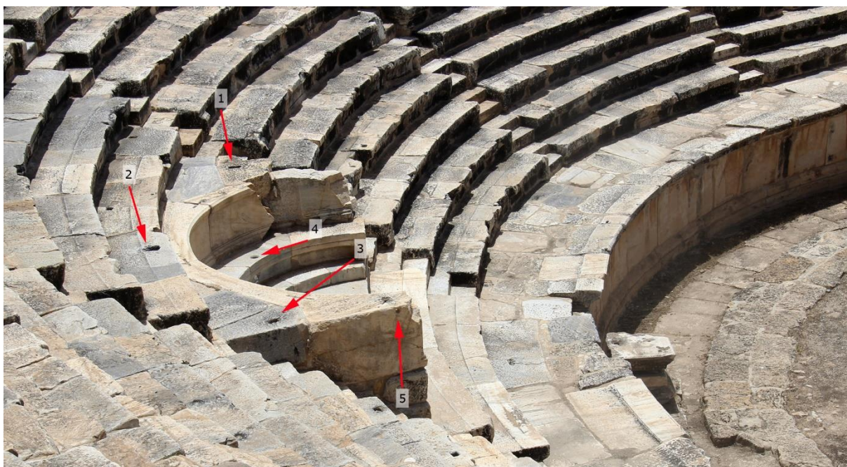
Figure 155 : Traces potentielles de l'implantation d'un vélum au-dessus de la loge d'honneur du théâtre de Hiérapolis (Turquie)
