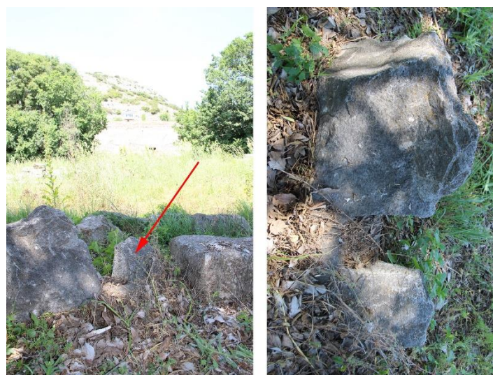
Figure 77 : Console brisée avec un trou débouchant derrière la scène du théâtre de Philippes
