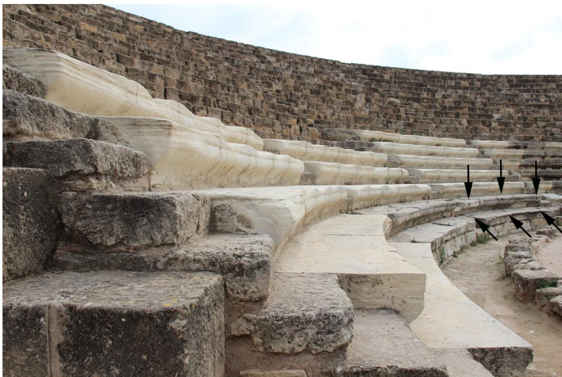
Figure 3 : Localisation des six trous d'encastrement et/ou débouchants repérés dans les gradins du théâtre de Salamine de Chypre
