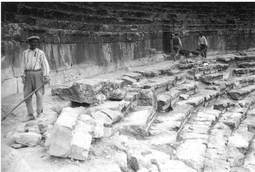
Figure 142 : Cauea du théâtre de Hiérapolis en cours de restauration
