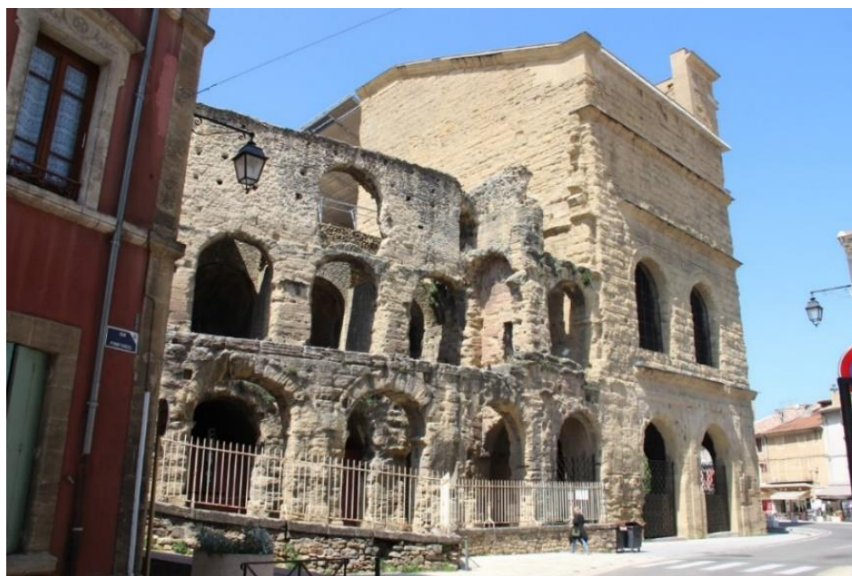
Figure 141 : Côté ouest du théâtre d'Orange au niveau de la liaison mur de scène/cauea
