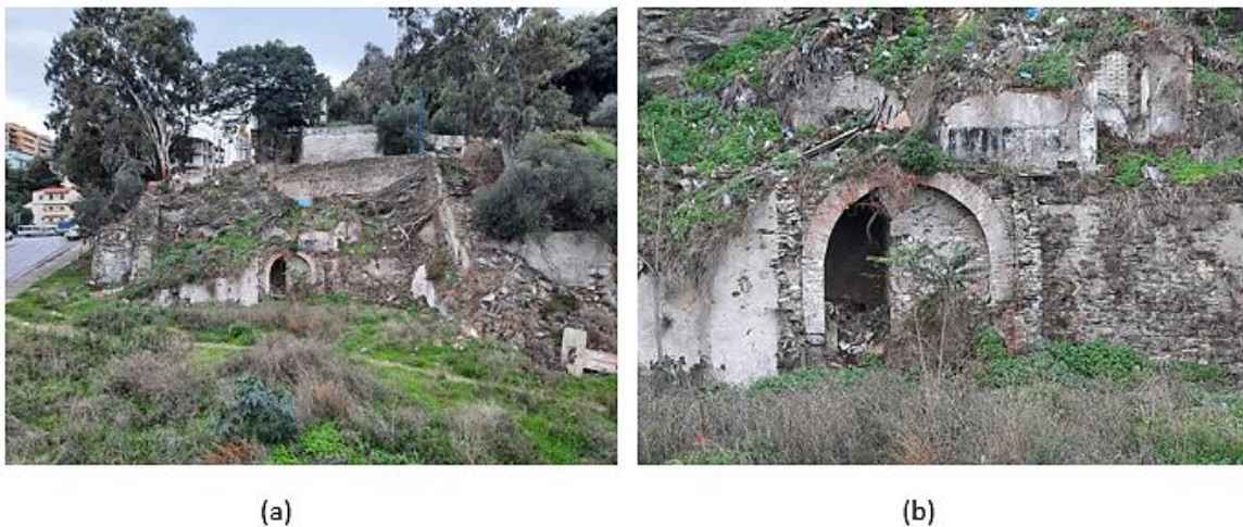
Figure 85. Les traces d'un passage sont apparues après l'effondrement de certains bâtiments coloniaux en face du port mixte (le vieux port de Skikda).
