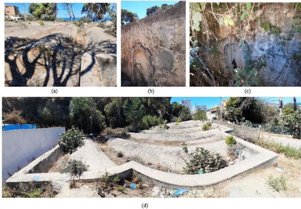
Figure 68. (a) (d) Une vue d'en haut sur les réservoirs de Bab Awras qui donne une vue sur le port mixte, (b) (c) les accès des réservoirs (fermés).
