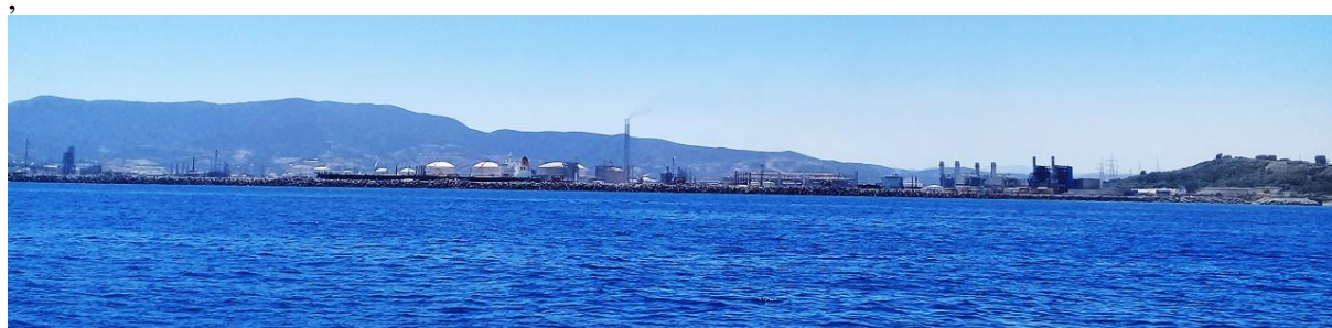
Figure 151. Une capture panoramique du terminal d'hydrocarbures du port d'El-Djadid.
