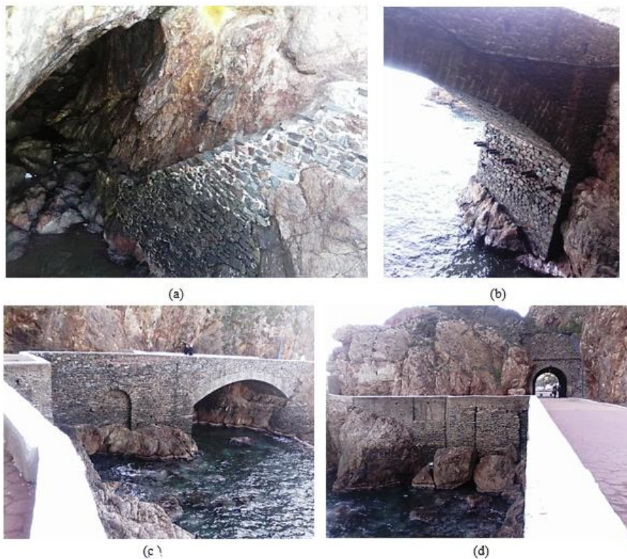
Figure 93. a, b, c, d Un panel des différentes captures de photos sur la grotte de Stora. (Source : Amira Ghennai, 2017).
