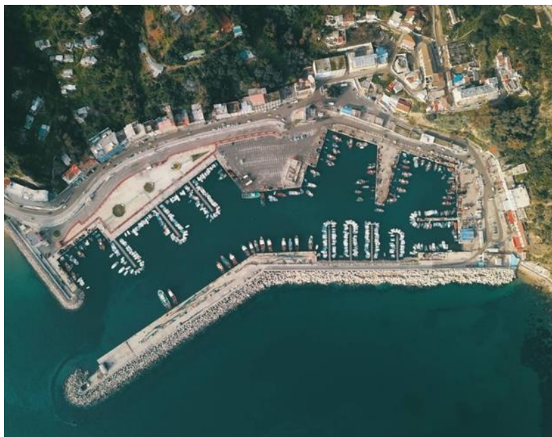
Figure 118. Vue du ciel sur le port de Stora. (Source : Moatez billeh Zoghmar, 2020).
