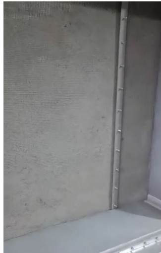
FIGURE 2.2 – Bloc de béton associé à un grillage et monté sur la cage de Faraday
