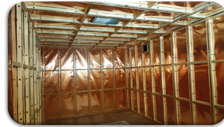
(b) Cage de Faraday avec feuillard de cuivre ( www.mri.com.tr )
