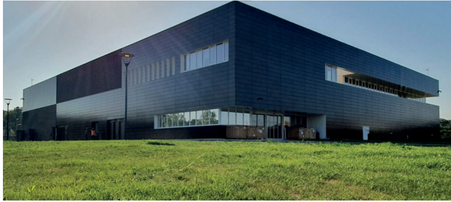
FIGURE 1.1 – Centre de Surveillance de la Sécurité Galileo (2022)
