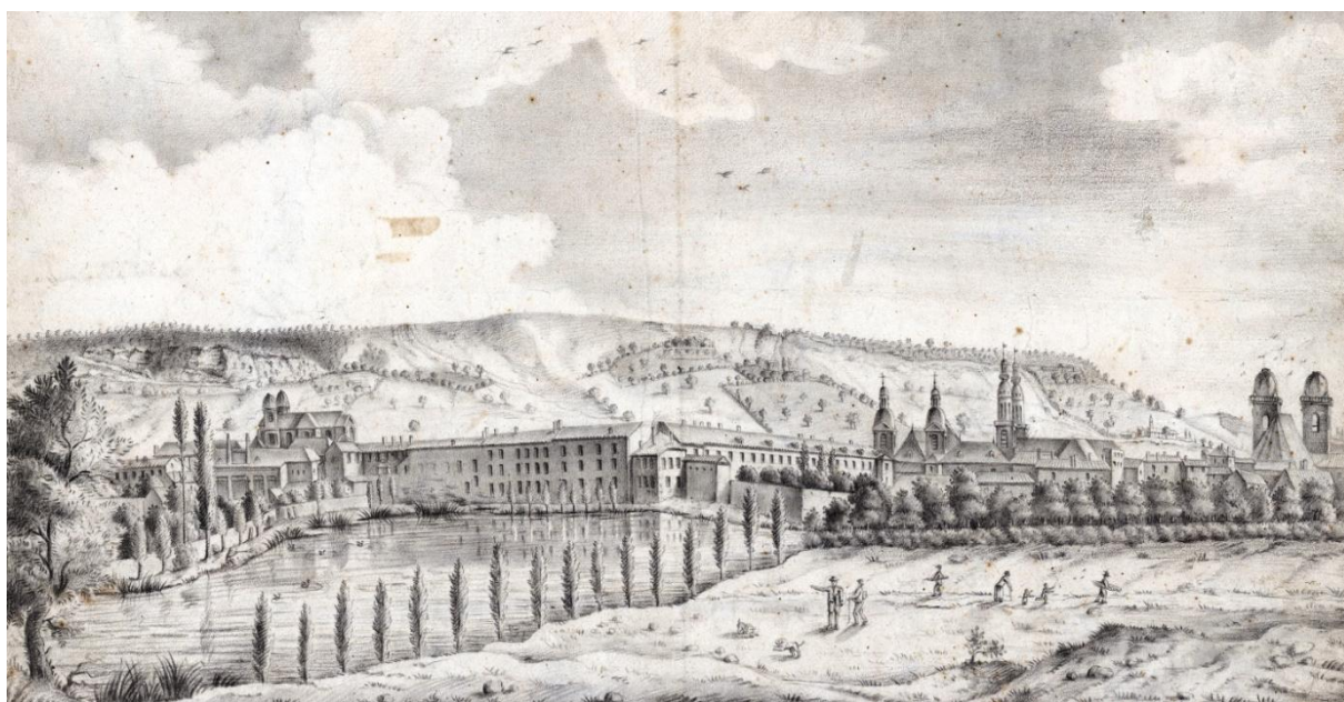
Figure 45 : Vue de Nancy depuis l'étang de Saint-Jean 3 . L'hôpital militaire est au centre de l'image (bâtiment en forme de « L » qui jouxte l'étang et ferme la ville).
