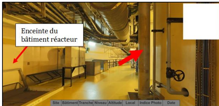
Figure 66. À gauche : mur extérieur du bâtiment réacteur ; à droite : conduite qui descend vers le deuxième local indiqué par l'EV se trouvant en dessous.
