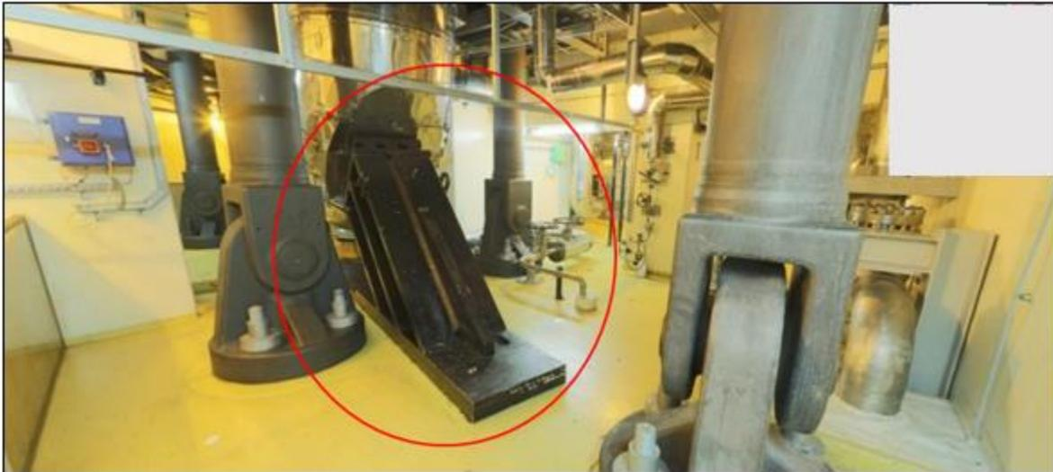
Figure 43. Cale antisismique (en noir) arrachée par la dilatation du tuyau.
