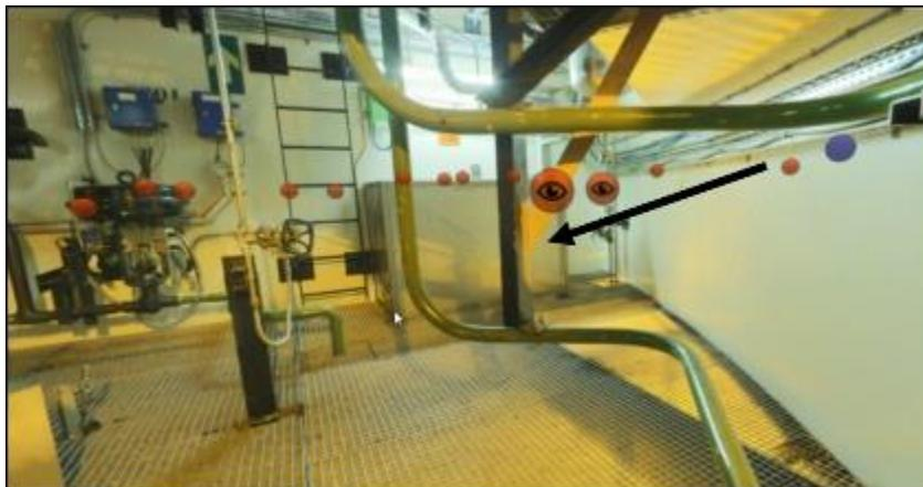
Figure 93. Plaquage derrière lequel se trouvent la vanne "cachée" et la vanne qu'ils ont vue.
