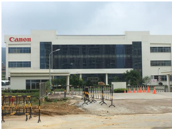
a. Le bâtiment principal de l'entreprise.
