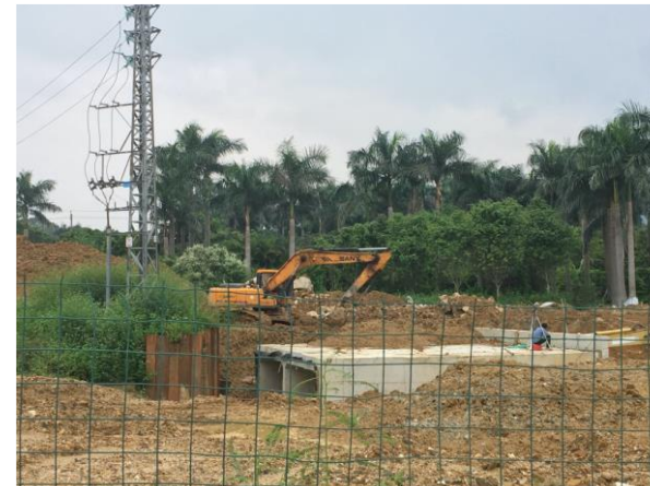
d. Le chantier de construction aux alentours de l'entreprise.
