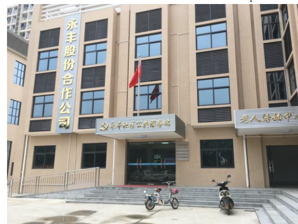
e. Le nouveau bâtiment de la société coopérative par action de l'ancien village de Yongfen. Le bâtiment héberge également le club du troisième âge et le centre de service du village.
