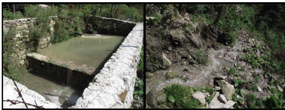
Figure 7.3 : Images de l'évacuation des eaux usées à Namche Bazar (septembre 2012)
