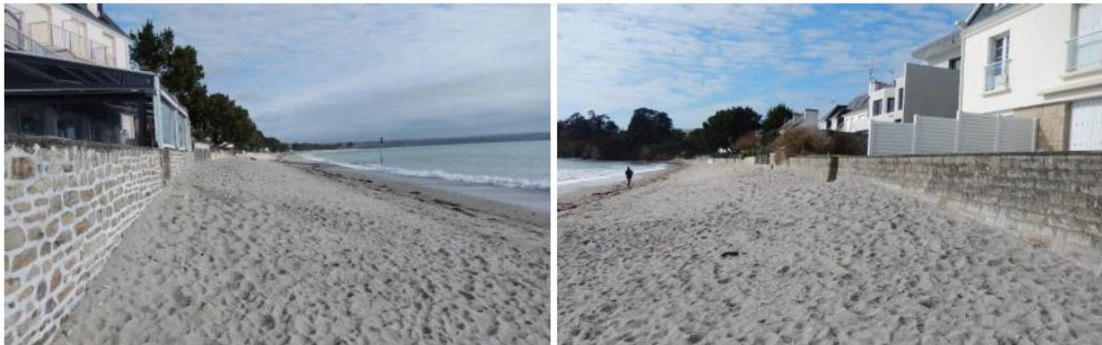
Figure 109 : Photographies issues du PPRL Est-Odet montrant les murets de protection du Cap-Coz construits par des particuliers (Source : PPRL Est-Odet)
