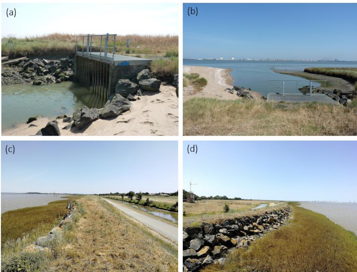
Figure 103 : Photographie de la digue de Corsept avec (a) l'exutoire unique au niveau de la pointe de l'Imperlay (b) Vue sur le complexe industriel de la rive Nord depuis l'exutoire unique (c) Vue vers l'Est depuis la digue vers l'exutoire unique, (d) Vue vers l'Ouest depuis la digue au niveau du port de la Maison Verte vers le bourg de Corsept (Photographie : Léa Paly, 2019)
