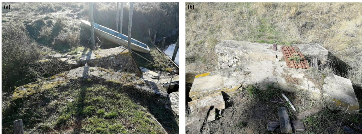
Figure 122 : Photographies des essailles (a) anciennes construites en pierre, (b) récentes construites en béton. (Photographie : Léa Paly, 2021)
