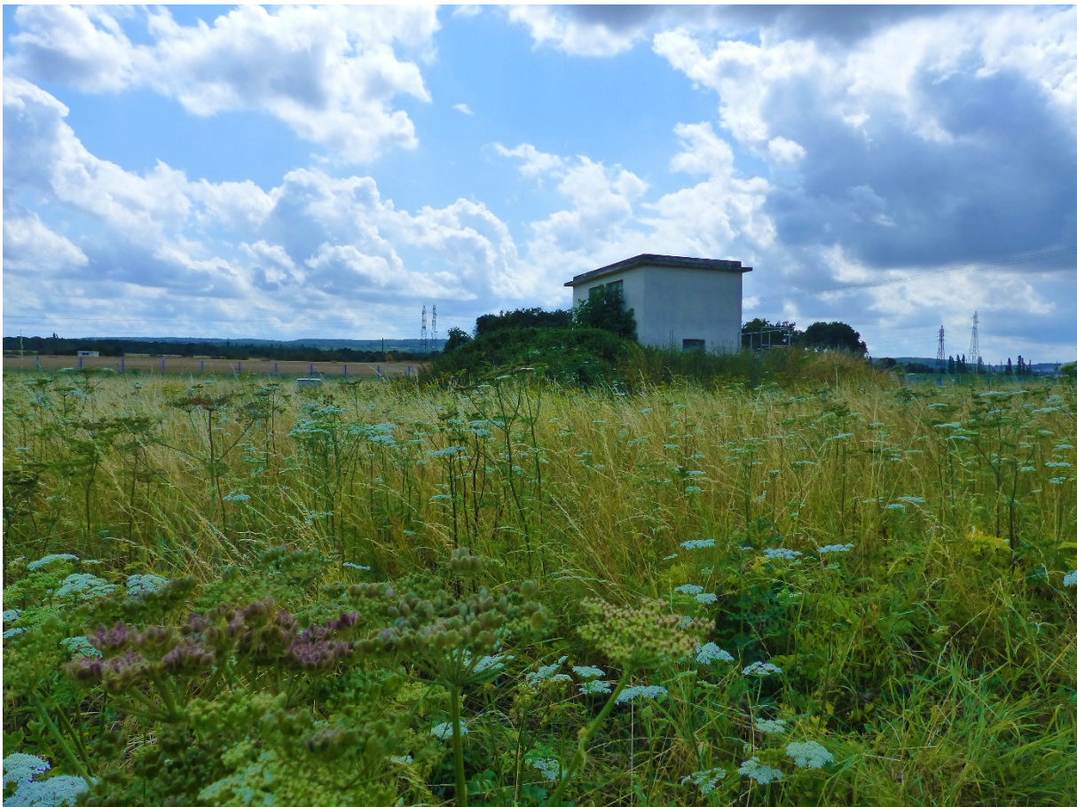
Figure 68 : Site de captage d'eau potable géré par SUEZ
