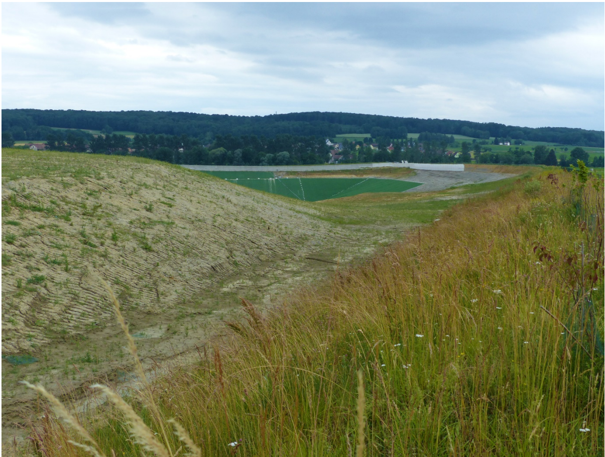
Figure 31 : Site pilote de Retzwiller © Chloé Thierry
