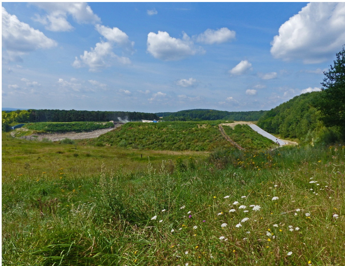
Figure 7 : Vue sur l'Installation de Stockage de Déchets de Villeneuve-sur-Verberie © Chloé Thierry
