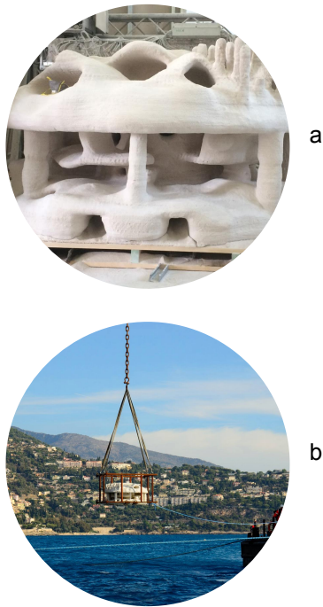
FIGURE 1.18 – Illustration d’un récif artificiel imprimé en 3D. a : vue d’ensemble, b : immersion du récif dans la réserve du Larvotto à Monaco
