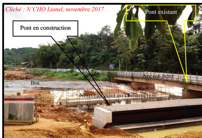
Photo 1 : Construction d'un pont sur la Bia dans la ville d'Aboisso
