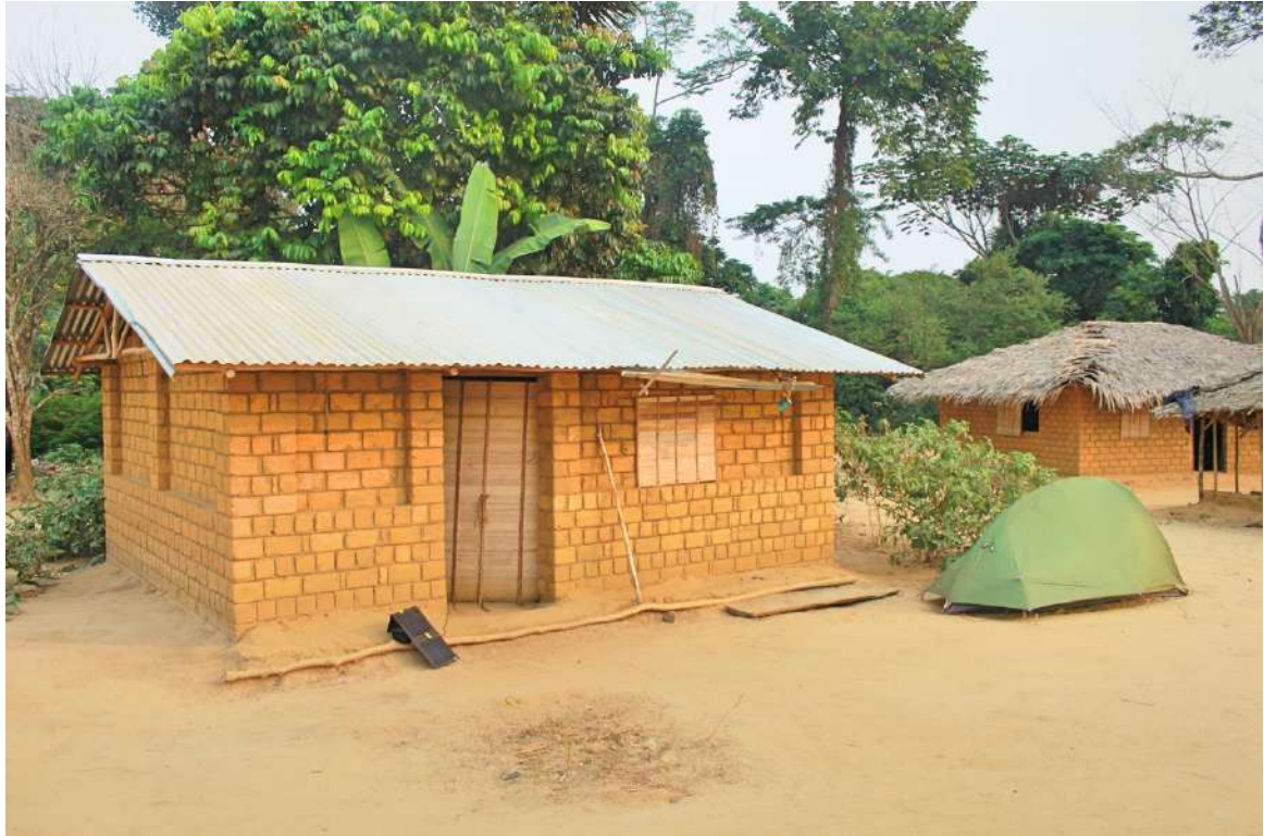
Photo 6.1 : Habitation avec toit de tôle à l'avant, et toit traditionnelle à l'arrière.
