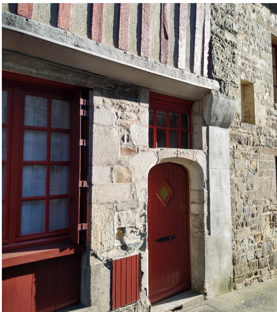
Photographie 6 : Une maison à pans de bois récemment rénovée dans le faubourg du Rachapt à Vitré, Charlotte Porcq, janvier 2020
