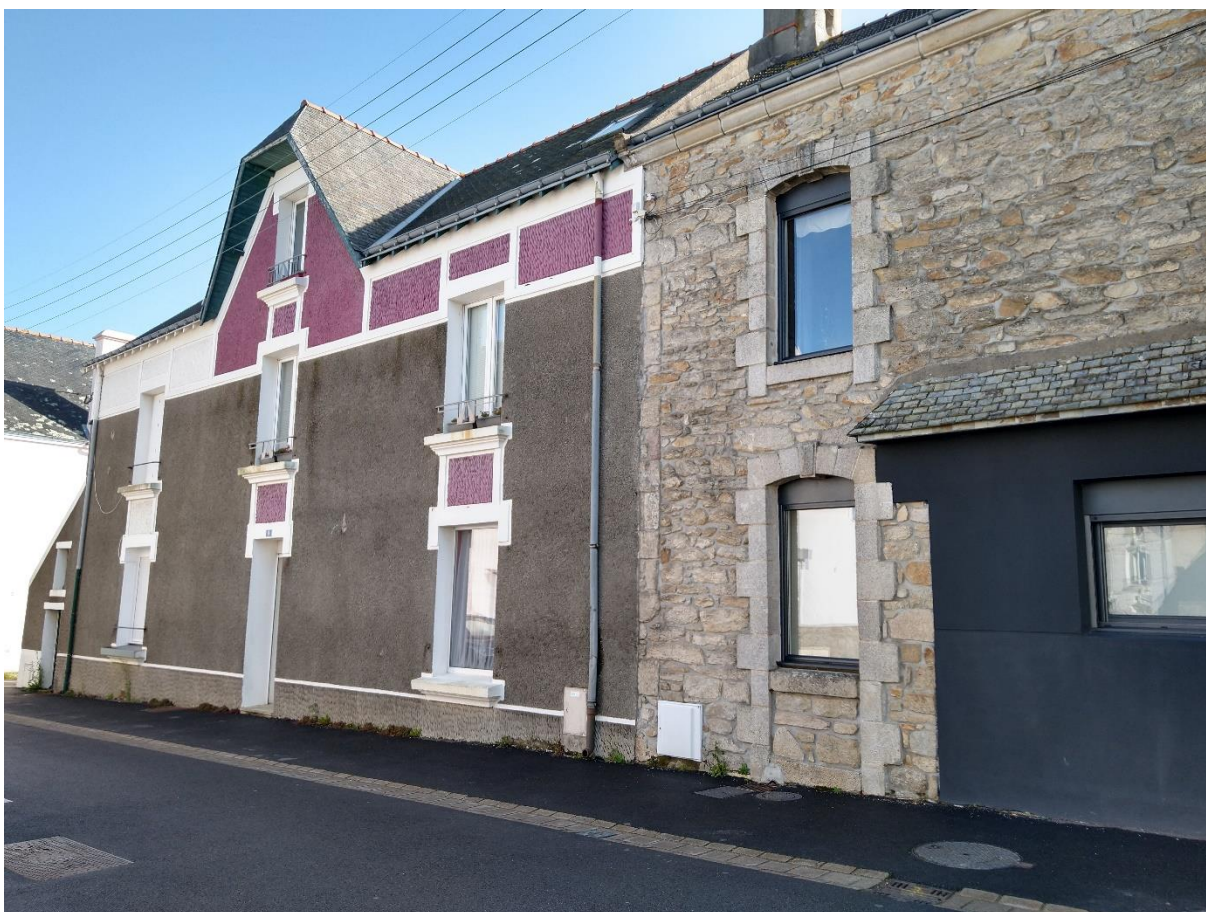
Photographie 9 : Les touches de couleur sur les maisons du centre-bourg de Riantec, à l'initiative des propriétaires et encouragées par la mairie. Elles rappellent les anciens bourgs de pêcheurs, où les peintures de coques de bateaux étaient utilisées pour décorer les façades. Photographies : Charlotte Porcq, octobre 2019.
