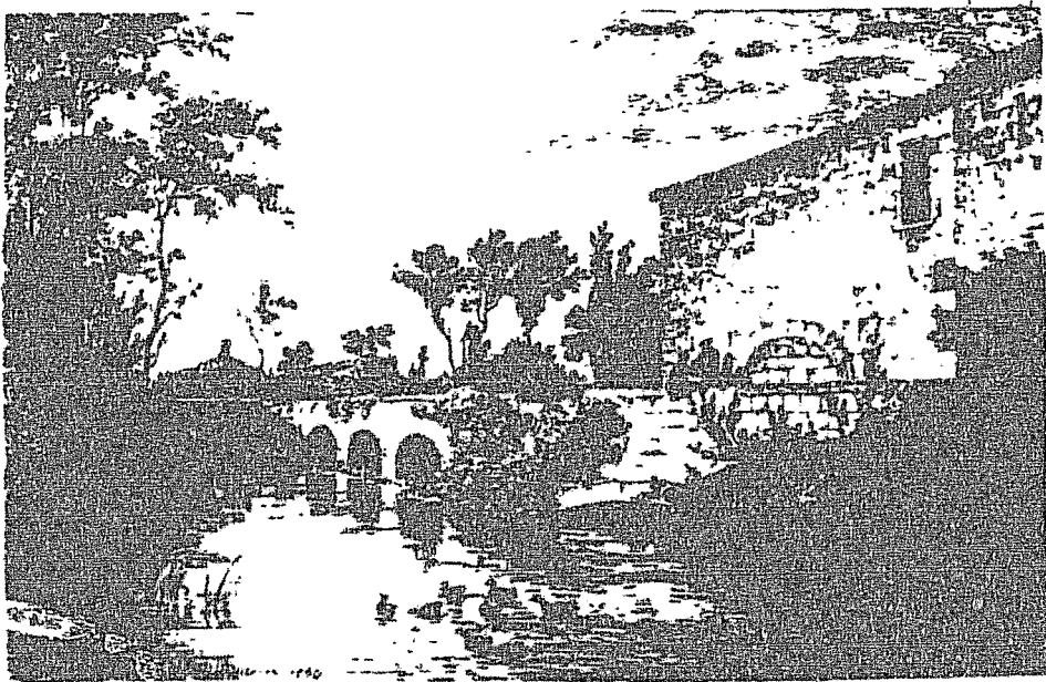
La chaussée du moulin de PONTDAURAT à Bassane.
