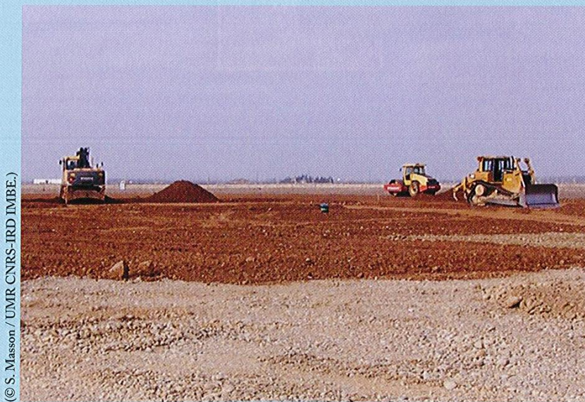
Figure 3.4. Remise en place des différentes couches de sol (cailloutis, horizon minéral et horizon organique) au printemps 2011 après le retrait du sol pollué par les hydrocarbures.
