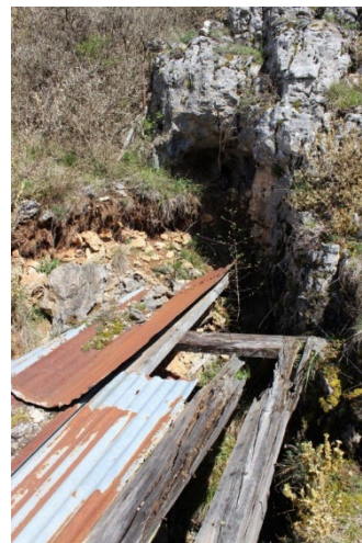
Figure 77 : Vergisson IV. Vue de la petite niche constituant le résidu de la cavité originelle dont on voit une partie de la paroi orientale à droite. Dans cette portion antérieure de la cavité, ce qui reste de la paroi occidentale est encore masqué par les dépôts de versant. Photo S. Soriano, avril 2018.
