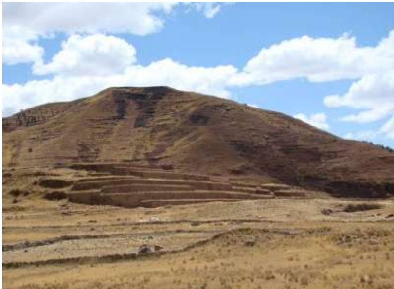
Figure 19 : Vue du système en terrasse du Qalasaya (la partie restaurée correspond à l'étage supérieur, au pied duquel s'étant le second système plus large)
