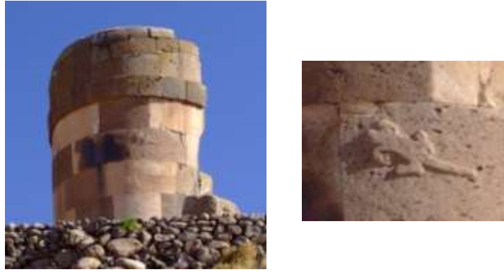
Figure 228 : La célèbre Chullpa del Lagarto de Sillustani, un exemple de l'architecture funéraire inca
