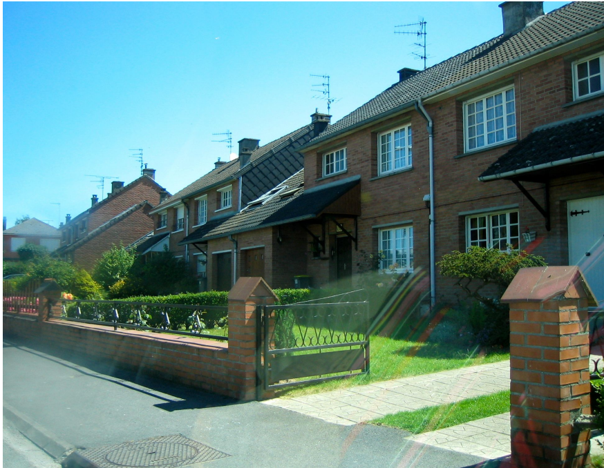
Figure 2-5. Maisons jumelées du groupe Martin-Martine à Cambrai
