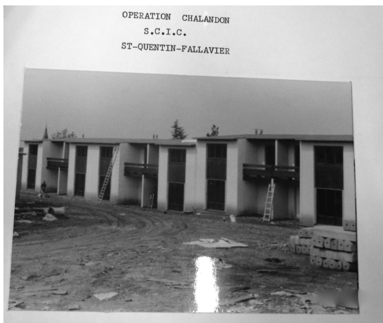
Figure 3-3. Chalandonnettes en cours de construction par la SCIC dans l'Isère
