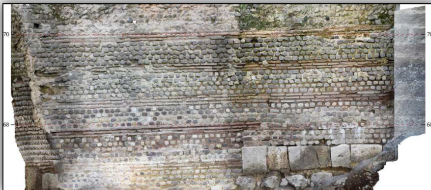
Figure 71 : Orthoimage d'un pan de la cortina romaine (source : S. Augry, Inrap)
