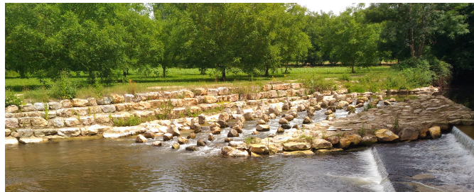
FIGURE 4.16 – Passe en enrochement sur la Bave, Saint Jean de Lespinasse (46)
