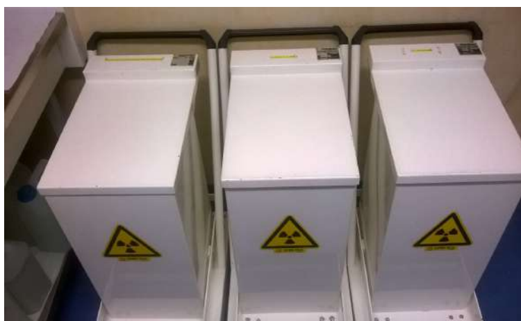
Photo 18 : Poubelles plombées en radiopharmacie (SNL)
