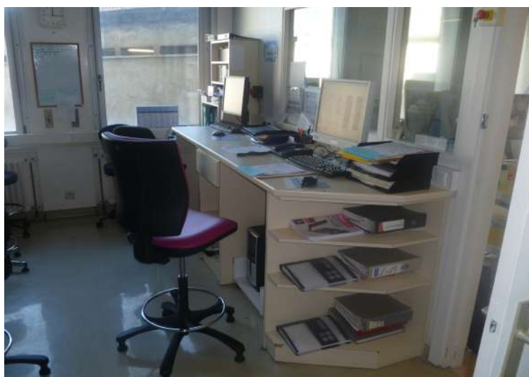
Photo 8 : Salle de commandes (SHD)
