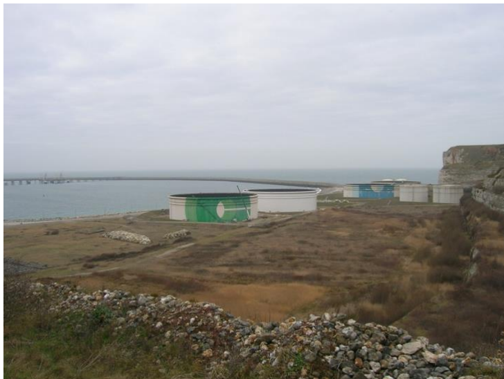
Photographie 2 : Les cuves et la digues du port pétrolier du Havre-Antifer (Auteur : B. Evrard, mars 2008).
