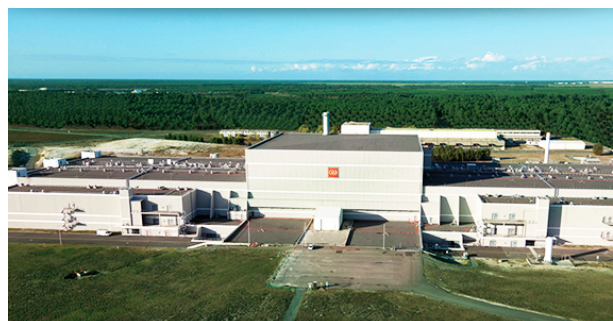
Photo 4 : Vue générale du bâtiment LMJ
