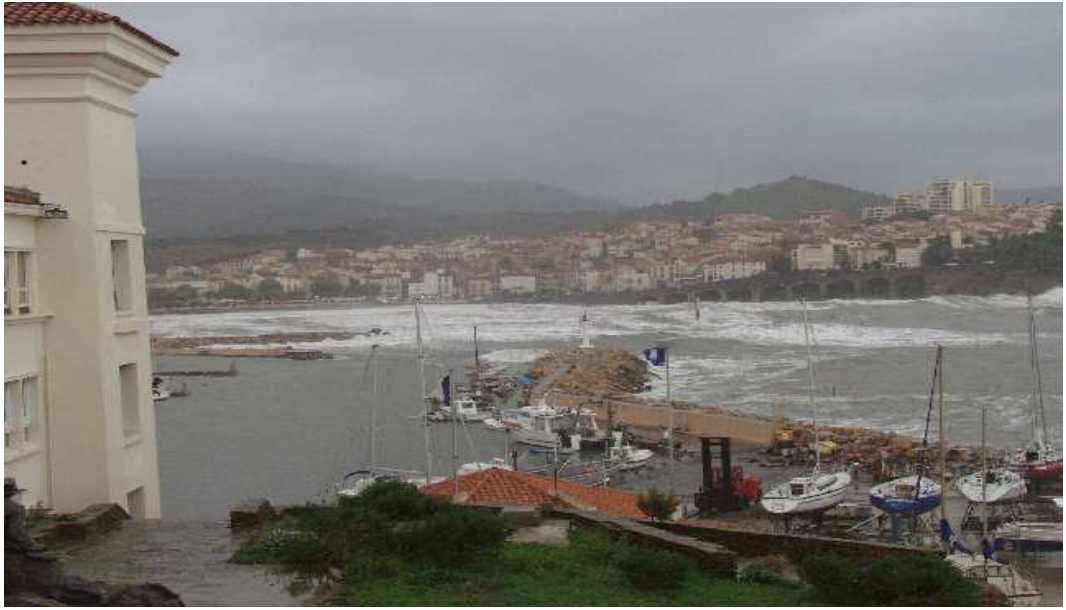
FIG. 1.3 – La baie de Banyuls sur Mer lors d'un épisode de tempête ( H_s = , T_m = , 18 Octobre 2008)
