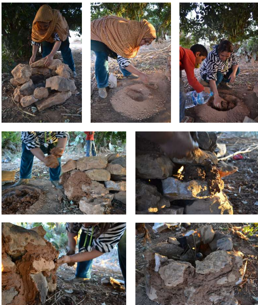
Figure 119 Construction d'un taghouni (Douar Ouaraben, région de Tiznit, 2016)
