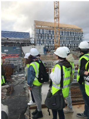
Figure 8 : visite de chantier sur le projet urbain « Viotte » à Besançon
