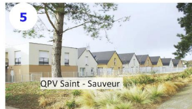
5 QPV Saint - Sauveur Quartier Saint-Sauveur, construction de 26 logements individuels dans le cadre du PNRU
