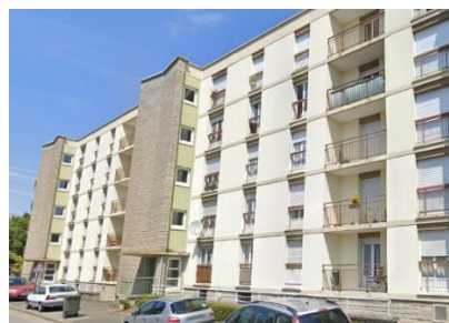
Immeubles collectifs PLA des années 1980 - centre-ville
