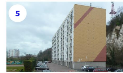
6 Graville-la-Vallée/Soquence Immeuble des années 1970
