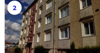
2 Pont- Féron- immeuble en attente de réhabilitation
