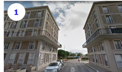
1 Centre-ville reconstruit- immeuble des années 1950 inspiré les normes constructives du plan Perret
