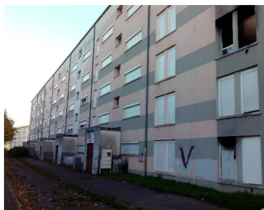
Immeubles prévus à la démolition dans un quartier ne relevant pas de la géographie prioritaire, Prés-Hauts, Tonnerre, Yonne
