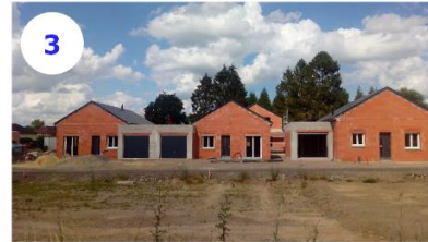
3 Clos- Morel- Reconstruction de 30 logements individuels après la démolition de 4 tours
