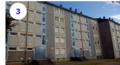
Quartier des Provinces, immeubles collectifs
