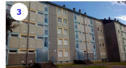
Quartier des Provinces, immeubles collectifs
