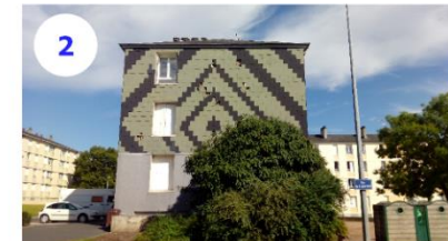
Quartier Vallée d'Auge, immeuble prévu à la réhabilitation dans le cadre du NPNRU
