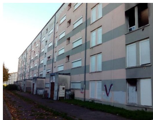
Immeubles prévus à la démolition dans un quartier ne relevant pas de la géographie prioritaire, Prés-Hauts, Tonnerre, Yonne
