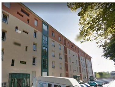
Immeubles des années 1960 réhabilités en logements étudiants
