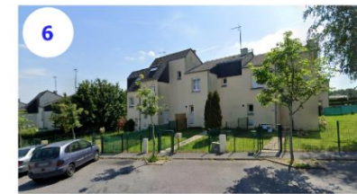
6 Saint-Germain du Corbéis, maisons mitoyennes construites dans les années 1980
