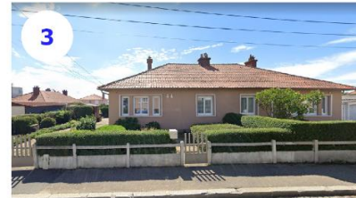
4 Aplemont - lotissement pavillonnaire reconstruit en 1956 après le bombardement du quartier
