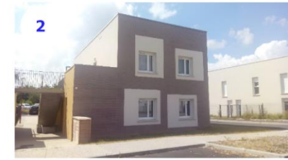
2 Blaizot- maisons construites en 2016, à la place d'immeubles démolis
