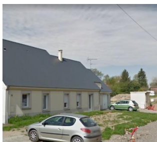
Lotissement pavillonnaire des années 2000
