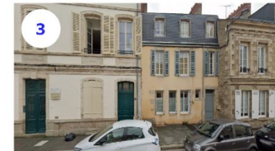
3 Centre-ville- Immeubles d'après-guerre, conventionnés en logement social en 1982
