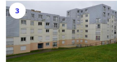
3 Les Vaux, immeuble des années 1970 prévu à la démolition
