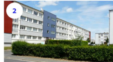
2 Blaizot- immeuble réhabilité
