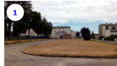
Quartier Saint-Michel, foncier disponible après démolition dans le cadre du PNRU
