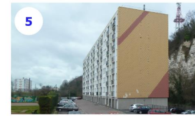
6 Graville-la-Vallée/Soquence Immeuble des années 1970
