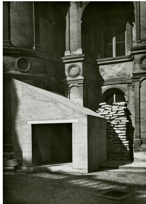
Fig. 67 : Abri maçonné au pied de la tourelle d'angle Nord-Ouest dans la cour du château, fenêtre protégée par des sacs de sable épreuve photographique, album noir 24A Seine-et-Oise, planche 15, © MAN, archives
