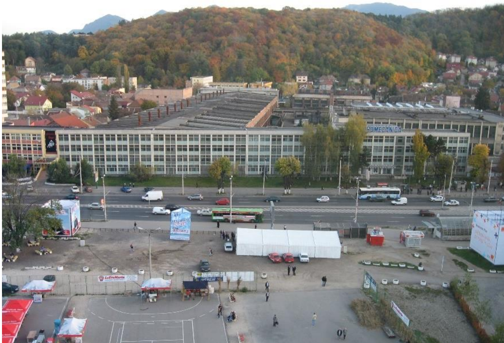
fig. 3. L'usine Hidromecanica (2006, AVM).
