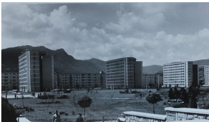
fig. 2. Le quartier de la Gare (années 1960-1970).
