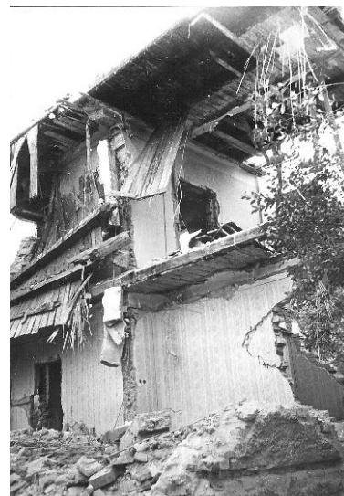
fig. 5. Démolition d'une maison dans le quartier, 1987 (AVM).
