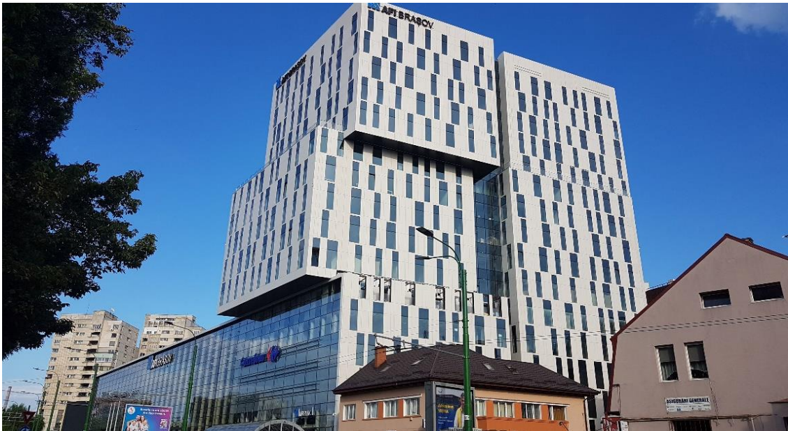
fig. 10. Nouveau bâtiment à la place de l'usine : un Mall et des espaces de bureau. (2020, B. Botea).
