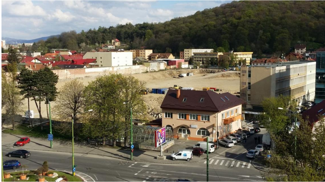
fig. 9. Démolition de l'usine Hidromecanica (2017, B. Botea).
