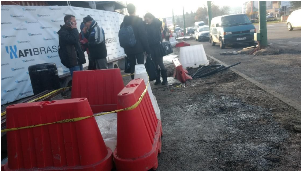
fig. 1, 2. Trottoirs devant le chantier du Mall, un arrêt de bus se trouve sur ce trottoir (2018, B. Botea).
