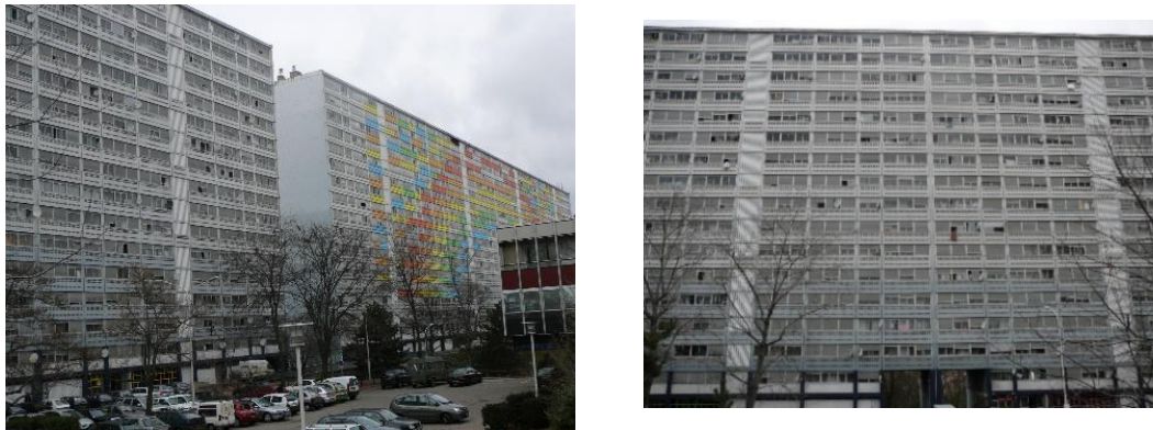
Fig. 7, 8. Immeubles démolis de la « Barre des mille » (2010, B. Botea).
