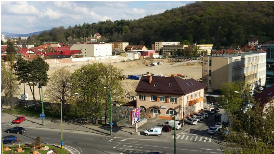
fig. 9. Démolition de l'usine Hidromecanica (2017, B. Botea).
