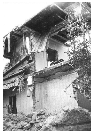
fig. 5. Démolition d'une maison dans le quartier, 1987 (AVM).
