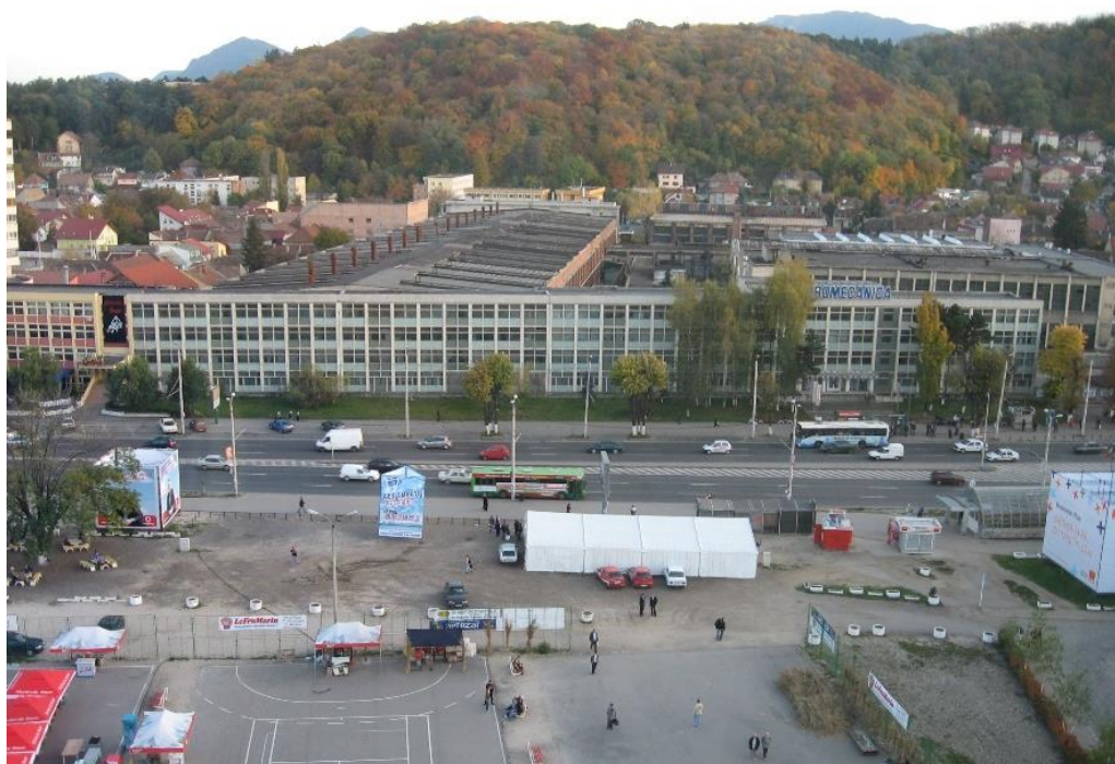
fig. 3. L'usine Hidromecanica (2006, AVM).
