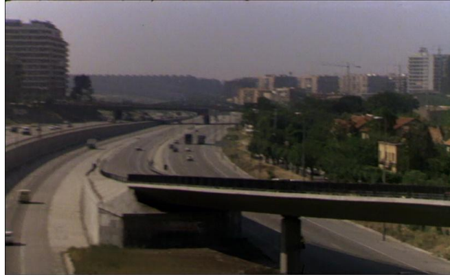
La rumba conduit le véhicule sur la rampe de lancement
