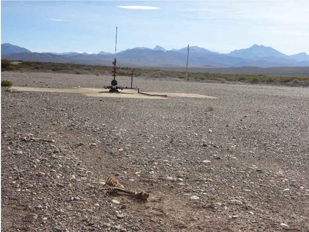
Ancienne plateforme d'exploitation désaffectée ©Tobias Etienne-Greenwood
