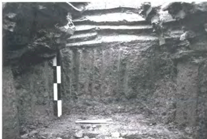
Fig. 8 — Vue de l'intérieur du four de tuilier 1, construit entièrement avec des tuiles liées à l'argile. Ce four, le plus petit, est doté de murs de soutènement réalisés par des empilements de demi-tegulae disposés en largeur, posés tête-bêche sur des colonnes formées par 3 ou 4 imbrices posées verticalement..
