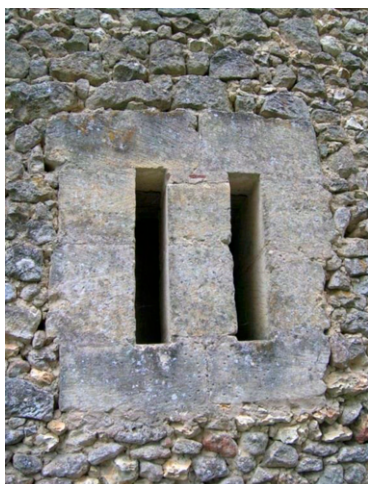
Figure 33. Regards pour le vannage, Villaines-les-Rochers (Indre-et-Loire) (Roux, 2015, p. 252).
