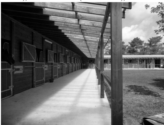
Figure 26. Écurie extérieure avec galerie sur poteaux (source internet).
