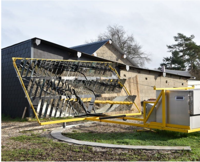
Figure I.12 : Four solaire pour torr efaction - boulangerie. Source :   Julien Lemaistre - Low-tech Lab.
