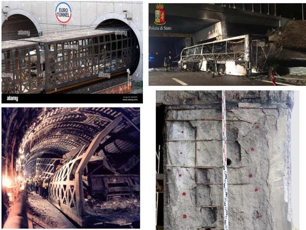
Figure II- 7 Deux cas illustrant l'impact d'un feu dans un ouvrage d'art : à gauche incendie dans le tunnel sous la Manche (1996) ; à droite, incendie d'un bus contre la pile d'un pont en Italie (2017, [19]). Les 2 photos supérieures montrent l'état post-incendie du véhicule où l'incendie s'est déclaré (poids-lourd dans une rame de train pour le tunnel, bus de tourisme pour le pont). Les 2 photos du bas illustrent l'état d'endommagement de la structure suite à l'incendie (voussoirs du tunnel et pile du pont), avec plus particulièrement un écaillage du béton très important.
