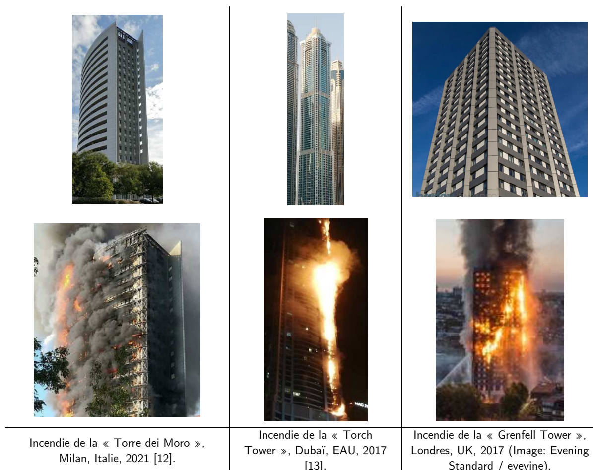
Figure II- 3 Trois cas d'incendies majeurs de tours d'habitation (en haut clichés avant incendie, en bas durant l'incendie).
