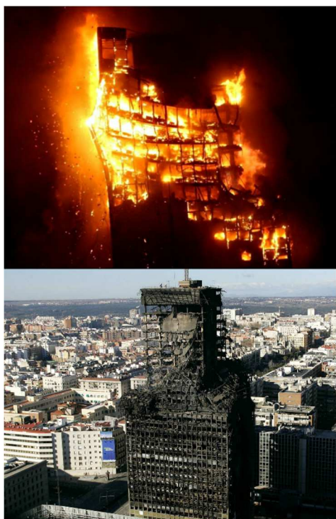
Vues de la tour Windsor, Madrid, Espagne durant et après l'incendie de 2017.
