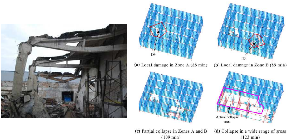
Figure II- 40 A gauche, vue de portiques (poutres en béton post-contraint) fortement déformés dans une usine polonaise suite à un incendie et à la ruine de portiques contigus [94]. A droite, simulations numériques de la ruine en chaîne d'un bâtiment de 8 étages en Chine suite à un incendie [95].
