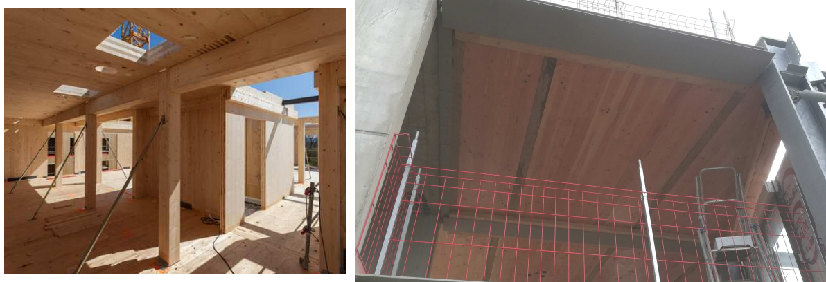
Figure II- 76 Exemples de projets d'immeubles avec utilisation du CLT. A gauche, projet « Sensations » à Strasbourg (Bouygues Immobilier maître d'ouvrage, Koz Architecture maîtrise d'œuvre, Eiffage Construction, entreprise de construction, crédit photo : Bouygues Immobilier). A droite, projet « Hyperion » à Bordeaux, (Bouygues Immobilier maître d'ouvrage, Koz Architecture maîtrise d'œuvre, Eiffage Construction, entreprise de construction, cliché personnel).
