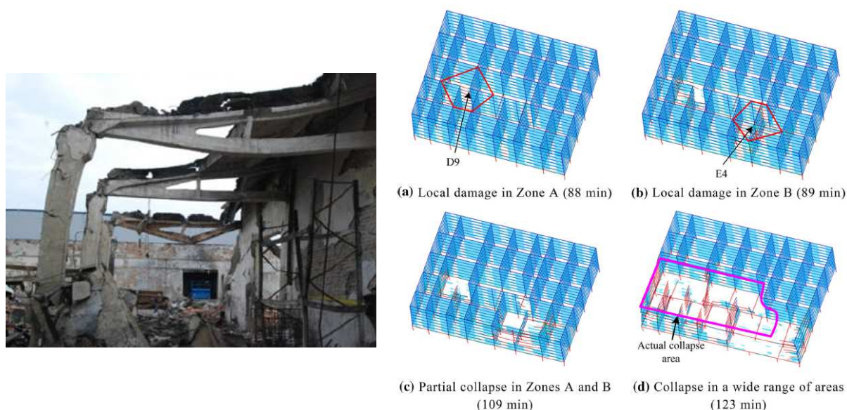
Figure II- 40 A gauche, vue de portiques (poutres en béton post-contraint) fortement déformés dans une usine polonaise suite à un incendie et à la ruine de portiques contigus [94]. A droite, simulations numériques de la ruine en chaîne d'un bâtiment de 8 étages en Chine suite à un incendie [95].
