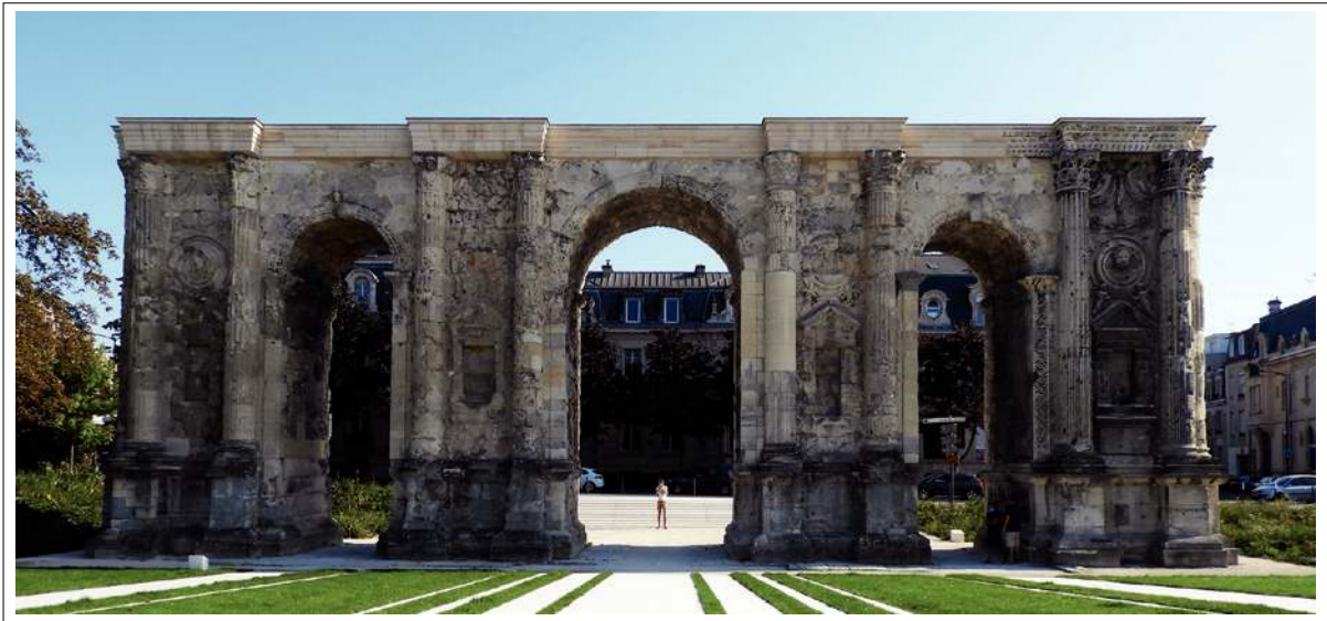
Figure III-1. Vue générale de la Façade Nord de la Porte de Mars
