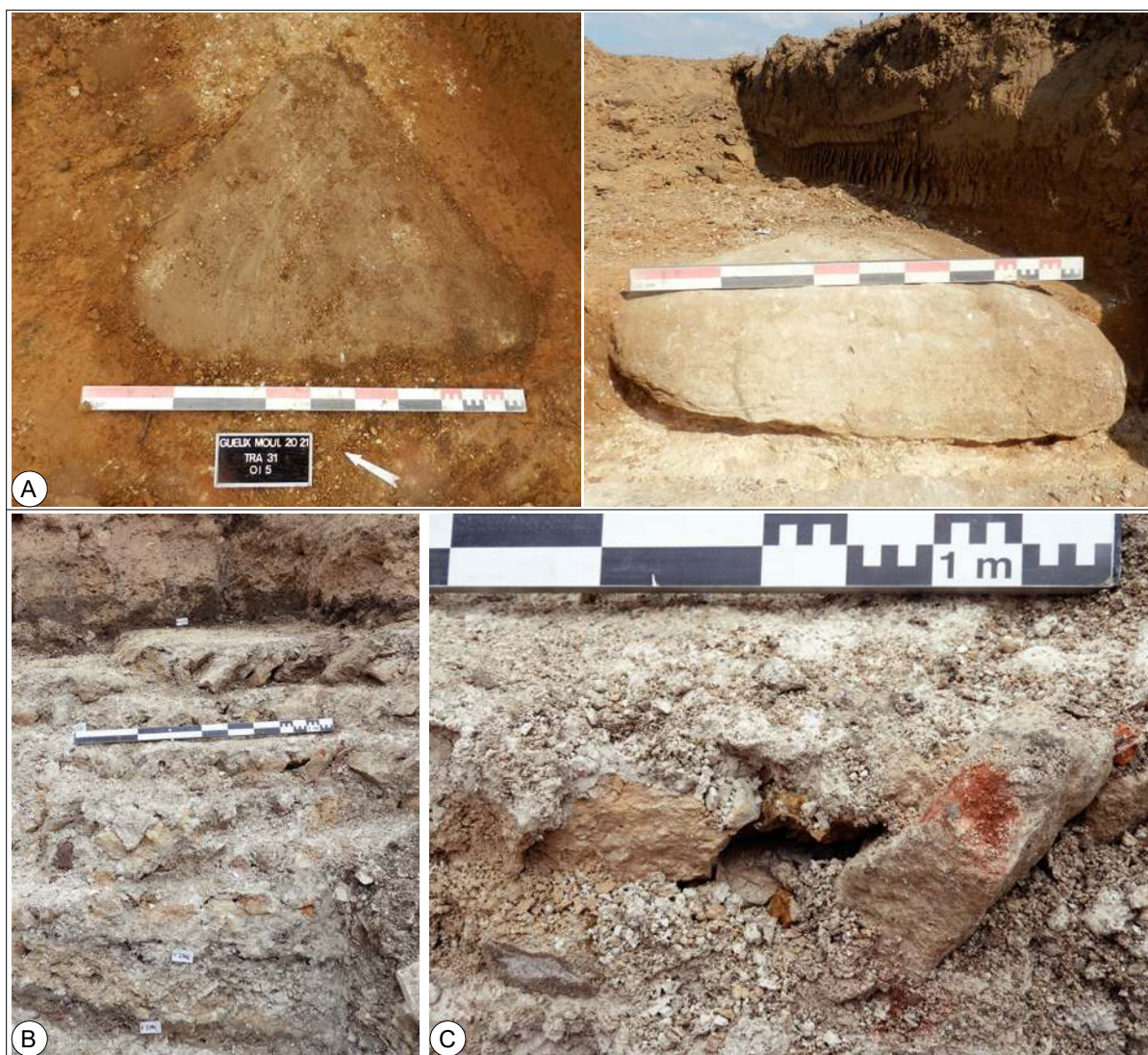
Figure II-9. Aperçus de matériaux relictuels et de leur utilisation dans les soubassements. A. Bloc de grès du Thanétien relictuel dans les limons quaternaires (diagnostic archéologique, Gueux) ; B. et C. Hérissons de fondation d'un grand édifice public obtenu par assemblage de moellons de meulière, de grès et de calcaires silicifiés dont une majorité porte des arêtes émoussées et liées suivant des assises successives par de la craie compactée (Fouilles de la Rue Marie Stuart).
