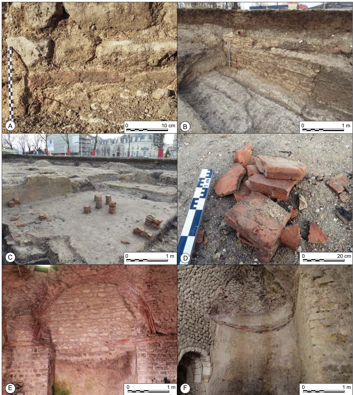
Figure II-11. Exemples de l'usage des terres cuites architecturales dans les constructions antiques A et B Terres cuites utilisées en assises de réglage dans les maçonneries des fouilles, de la rue Marie Stuart (A) et des Hautes promenades (B) ; C. et D. Briquettes de terre cuite assemblées en tant que pilettes d'hypocaustes exhumés dans les fouilles des Hautes promenades ; E et F : Utilisation des terres cuites en assises de réglage et comme arc de décharge dans les substructures du Cryptoportique de Reims.
