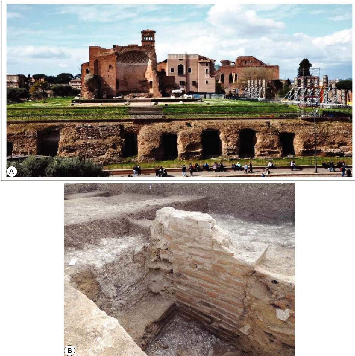
Figure I-37. A. Vue des ruines de grands édifices publics à Rome intégralement érigée en briques ; B. Exemple de l'opus testaceum dans la construction antique rémoise (photo R. Bontrond, SAGR).
