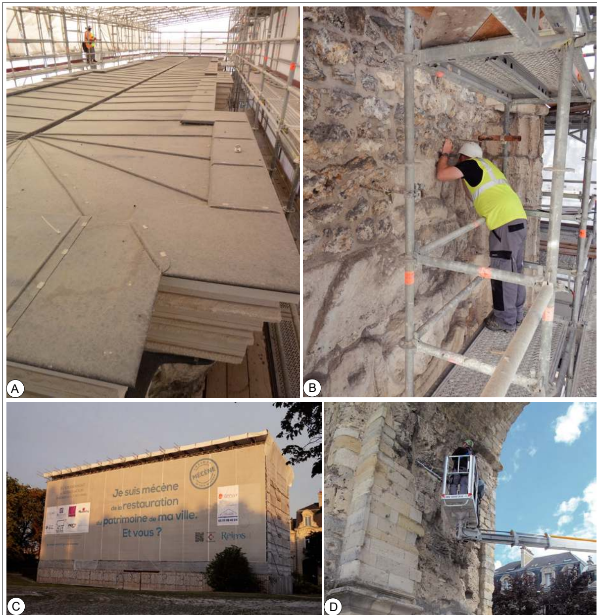
Figure III-24. A. Nouvelle couverture du monument mise en place en 2016 ; B. Description des pierres du sommet de la façade est depuis l'échafaudage ceignant le monument ; C. Vues extérieure de la Porte de Mars échafaudée en 2016 ; D. Description des pierres des façades des baies de l'Arc à l'aide d'une nacelle ciseau.
