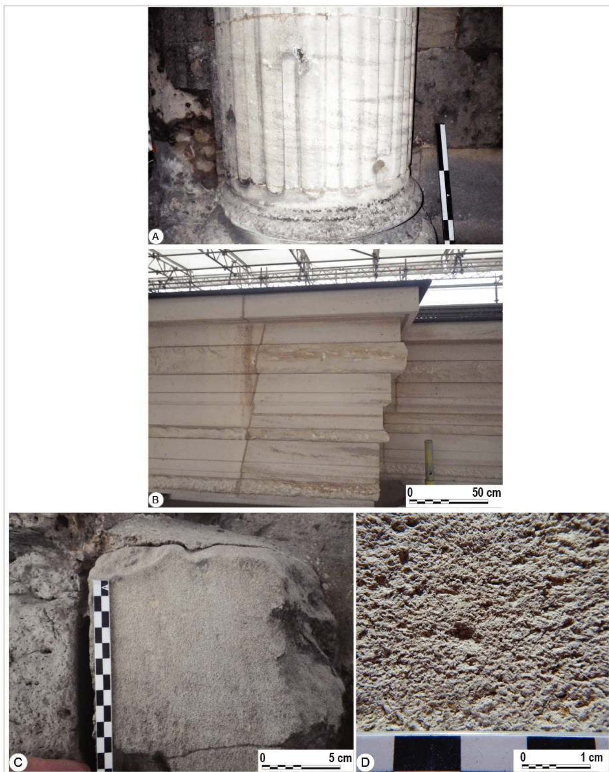
Figure III-49. Photographie du faciès type des calcaires à « oolithe vacuolaire » de type pierre de Savonnière. A ; Base de colonne restaurée au XIXe siècle ; B : Pseudo-attique de couverture construit en 2016 ; C : Moellon de restauration du XIXe siècle ; D : Aperçu macroscopique des calcaires oolithiques.
