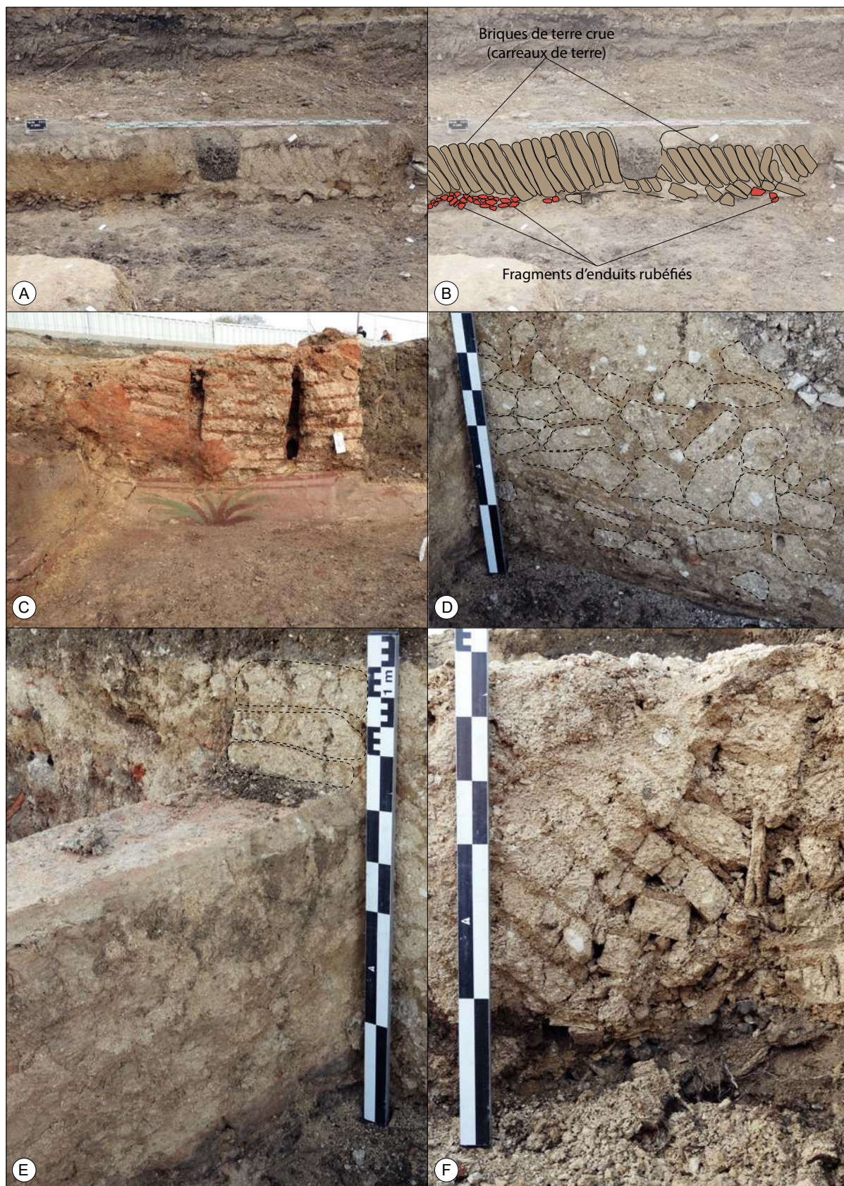
Figure II-8. Exemples de découvertes de carreaux de terre dans les élévations de constructions domestiques privées observées lors des fouilles des Hautes promenades à Reims en 2018. A et B restes des élévations d'un mur dont l'effondrement d'un bloc a préservé les matériaux et leur organisation. C. Reliefs de mur enduit en carreaux de terre dont les pans de bois ont disparu. D. Restes de carreaux de terre au pied d'un mur bahut. E. Mur bahut en place surmonté de 3 assises préservées de briques crues. F. Mur en carreaux de terre partiellement effondré.
