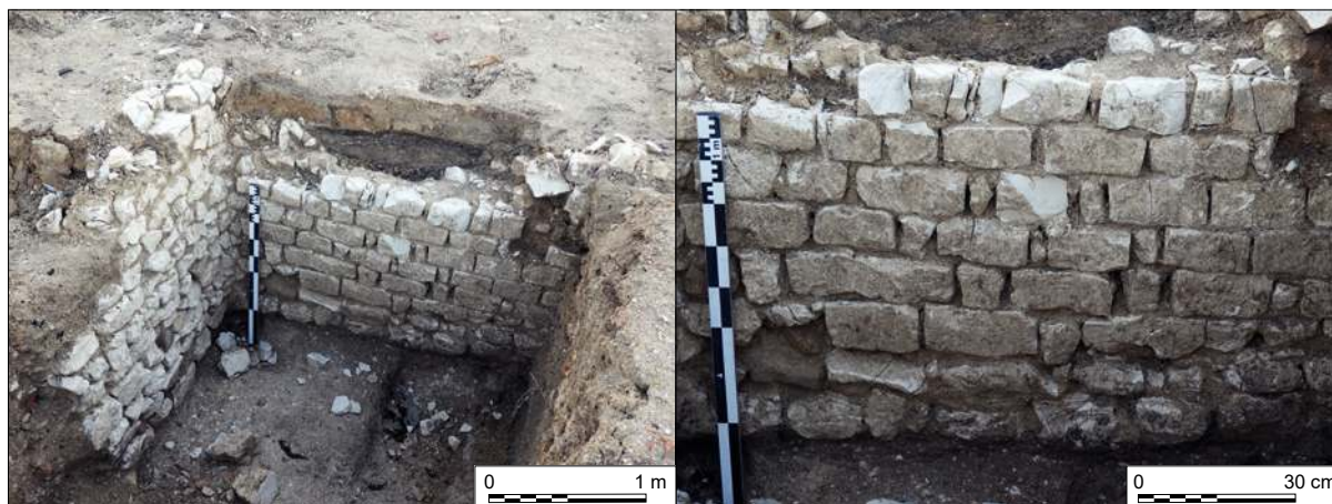
Figure II-4. Exemple d'utilisation de la craie mise en œuvre comme parement des murs d'une cave antique. Fouille des Hautes promenades, Reims (R.O. B. Panouillot, SAGR).
