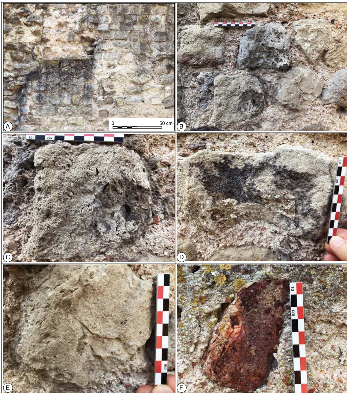
Figure II-47. Aperçu des modalités d'assemblage des maçonneries et des faciès les plus représentés dans les moellons des élévations du Cryptoportique (mur de la Façade Est du bâtiment). A et B. Assemblage en petit appareil des élévations du monument ; C. Calcaire massif à nombreux Ditrupa et lamellibranches ; D. Calcaire massifs à Ditrupa et gros grains de quartz ; E. Moellon de grès quartzite gris F. Moellon de pierre meulière (sa couleur très rouge découle d'une exposition au feu).
