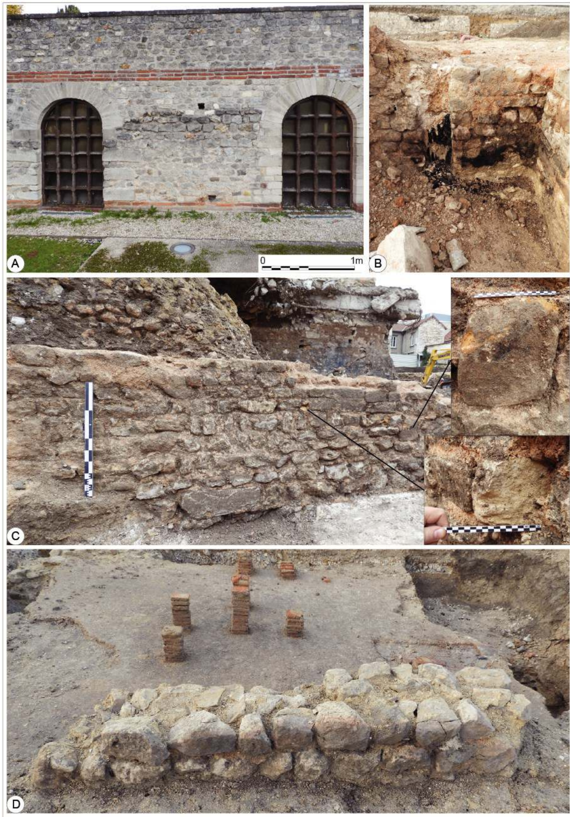
Figure II-15. Exemples d'utilisations de moellons de différentes natures dans des maçonneries. A. Murs de soubassement du Cryptoportique de Reims, seule la partie inférieure (plus sombre) est antique B. Murs bahut de Domus aux moellons bien équarris mêlant des pierres de natures très diverses et laissant apparaître au centre de l'image les restes d'une poutre en bois carbonisée (Hautes Promenades) ; C. Mur de soubassement d'un grand édifice public associant des calcaires à des grès quartzite (Rue Marie Stuart, Reims) ; D. Mur d'une Domus incendiée en moellons calcaires ( opus incertum ; Hautes Promenades).
