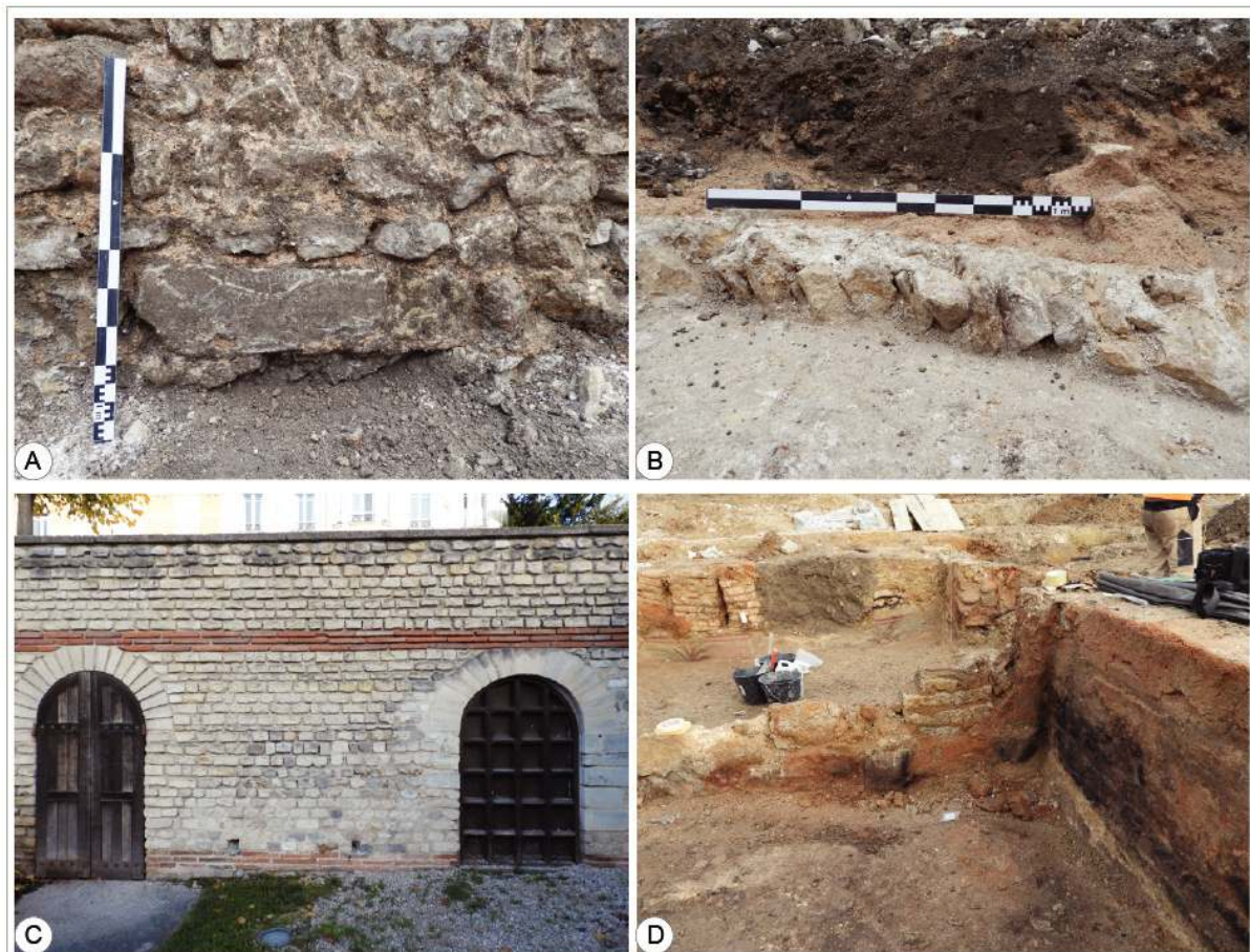
Figure I-36. Exemples d'appareils observés sur des maçonneries antiques à Reims. A. opus incertum , soubassements de la fouille de la rue Marie Stuart, 2018 ; B. Appareil en hérission sur le même site de la rue Marie Stuart ; C. Opus vittatum associé à de l' opus mixtum , murs extérieurs du cryptoportique de Reims (la partie haute à partir des départs de voûtes est restaurée) ; D. Restes des murs bahuts caractéristiques de l' opus craticium de soubassement de l'habitat antique à proximité de la Porte de Mars.
