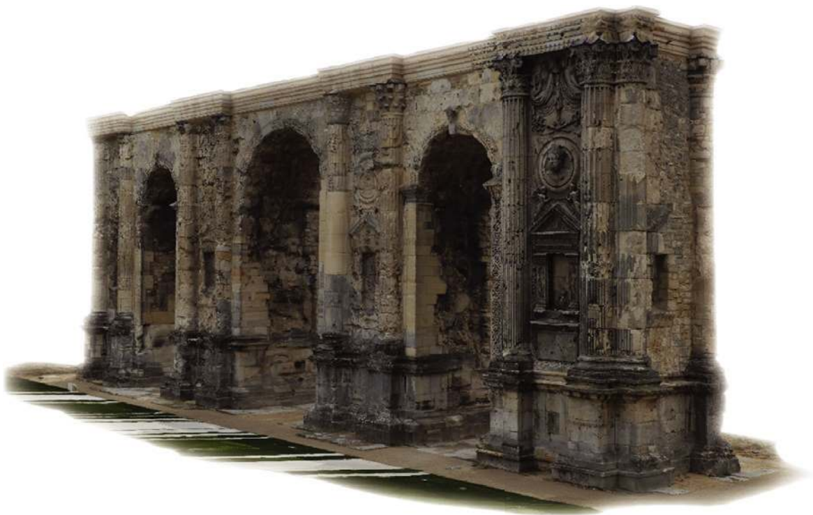
Maquette numérique 3D obtenue par photogrammétrie de la Porte de Mars, Reims
