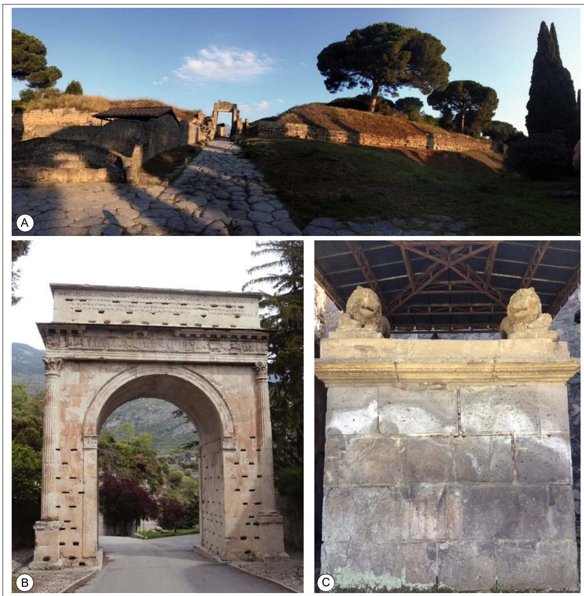
Figure I-34. Exemples de grand appareil quadrangulaire : A- Murailles en grand appareil de la ville antique de Pompéi et de la Porta Nocera ; B- Arc de Suse (cliché V. Brunet-Gaston), et C. vue du Mausolée 28 du secteur est de Pompéi..
