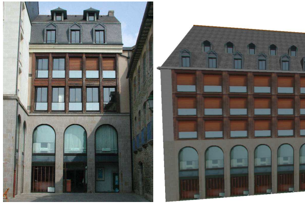
FIG. 4.12 – Reconstruction du second bâtiment.
